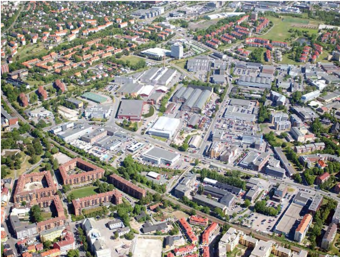
Figur 15. Foto av Ensjo før transformasjon.
