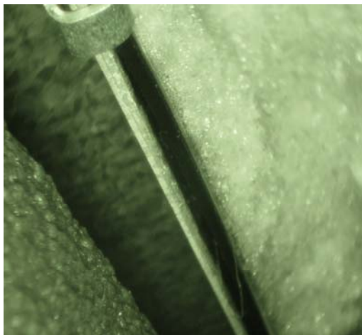
Figur 5-8 Is på pakning og vegg mellom kald friskluft og kald avtrekksluft
