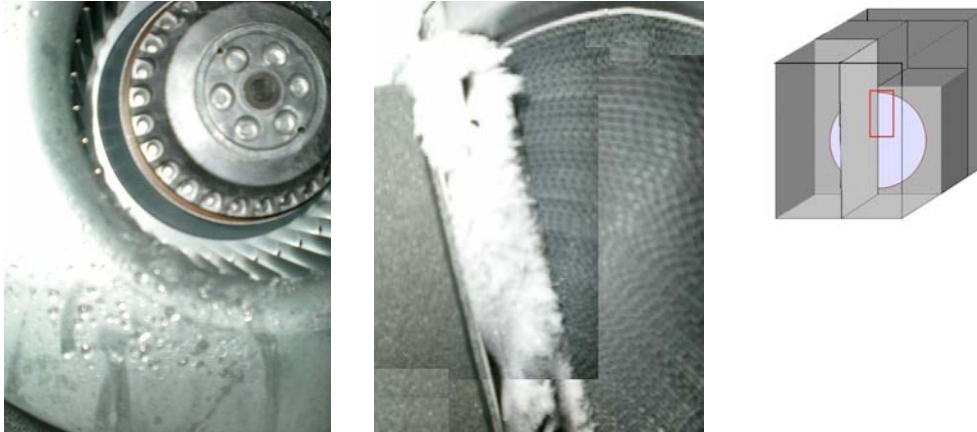
Figur 5-11 Kondens og is i aggregatet etter 19 timer
