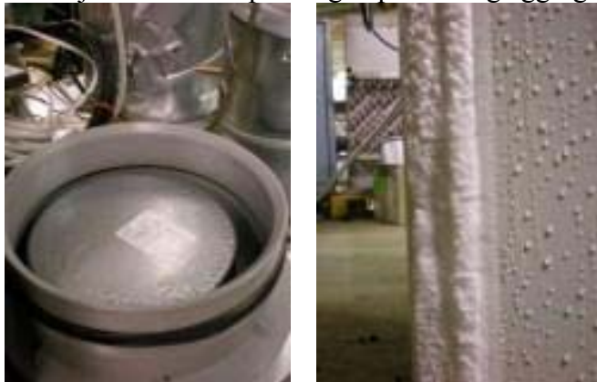
Figur 5-5 Is og kondens utenpå aggregatet
