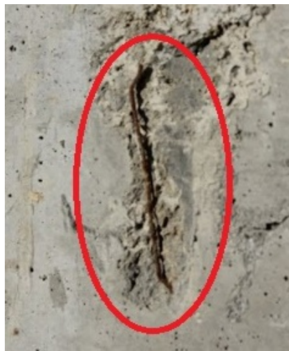
Figur 6.1: Parkeringsdekket på Munkvoll er støpt med rette fiber med endekroker. Foto: M. Sivertsen.
