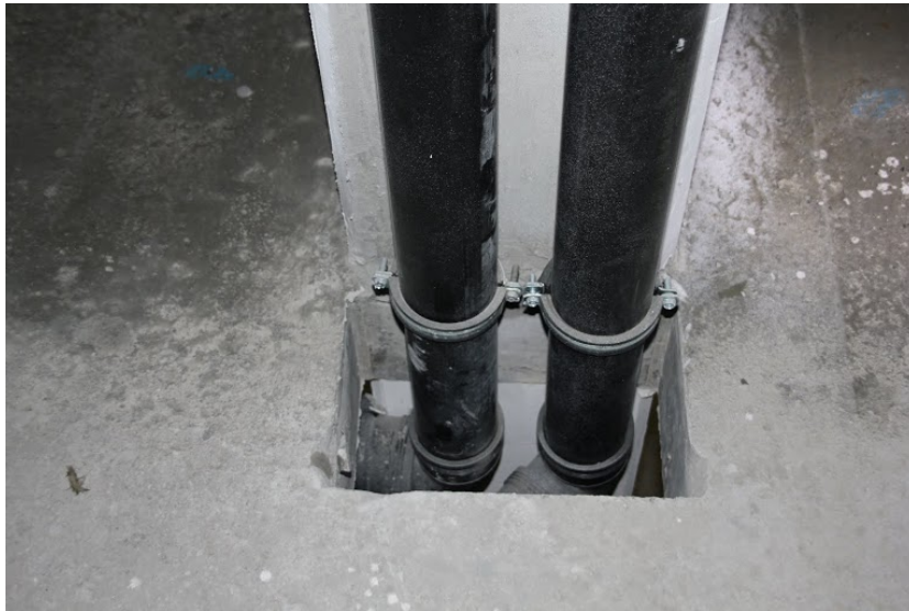
Figur 6.3: Utsparing til rør i dekket ved søylene. Foto: M. Sivertsen.
