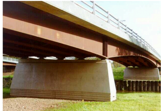
(B) KOMPOSITTBJELKE AV STÅL OG BETONG
