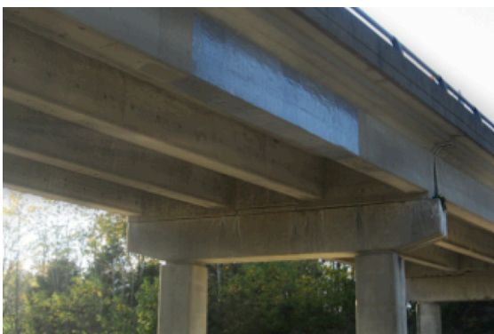
(C) T-BJELKER BRUKT I BRO
