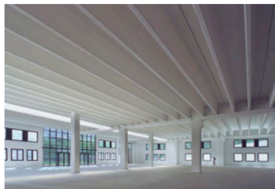
(D) PREFABRIKTERTE DT-ELEMENTER
