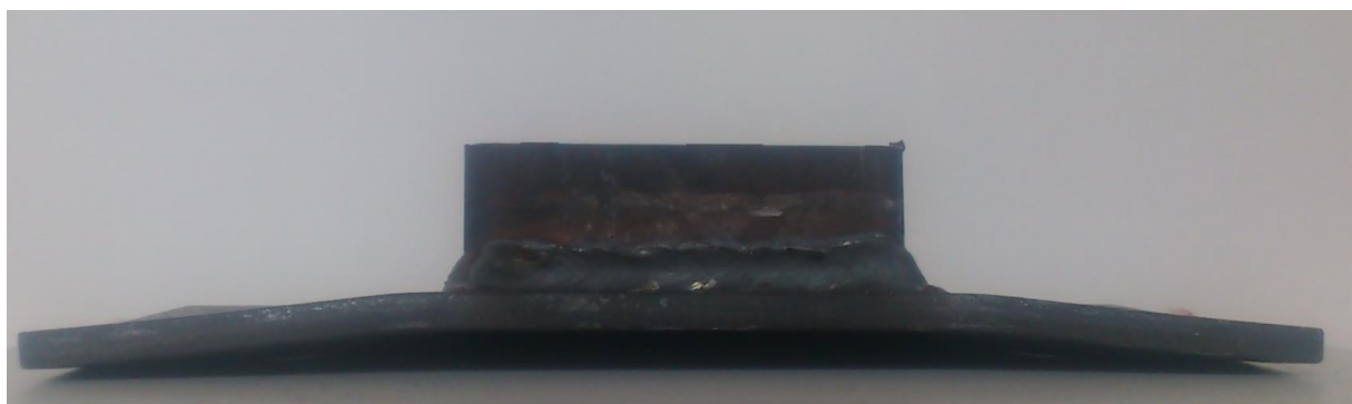
Figur 109: Deformasjonen sett bakfra.
