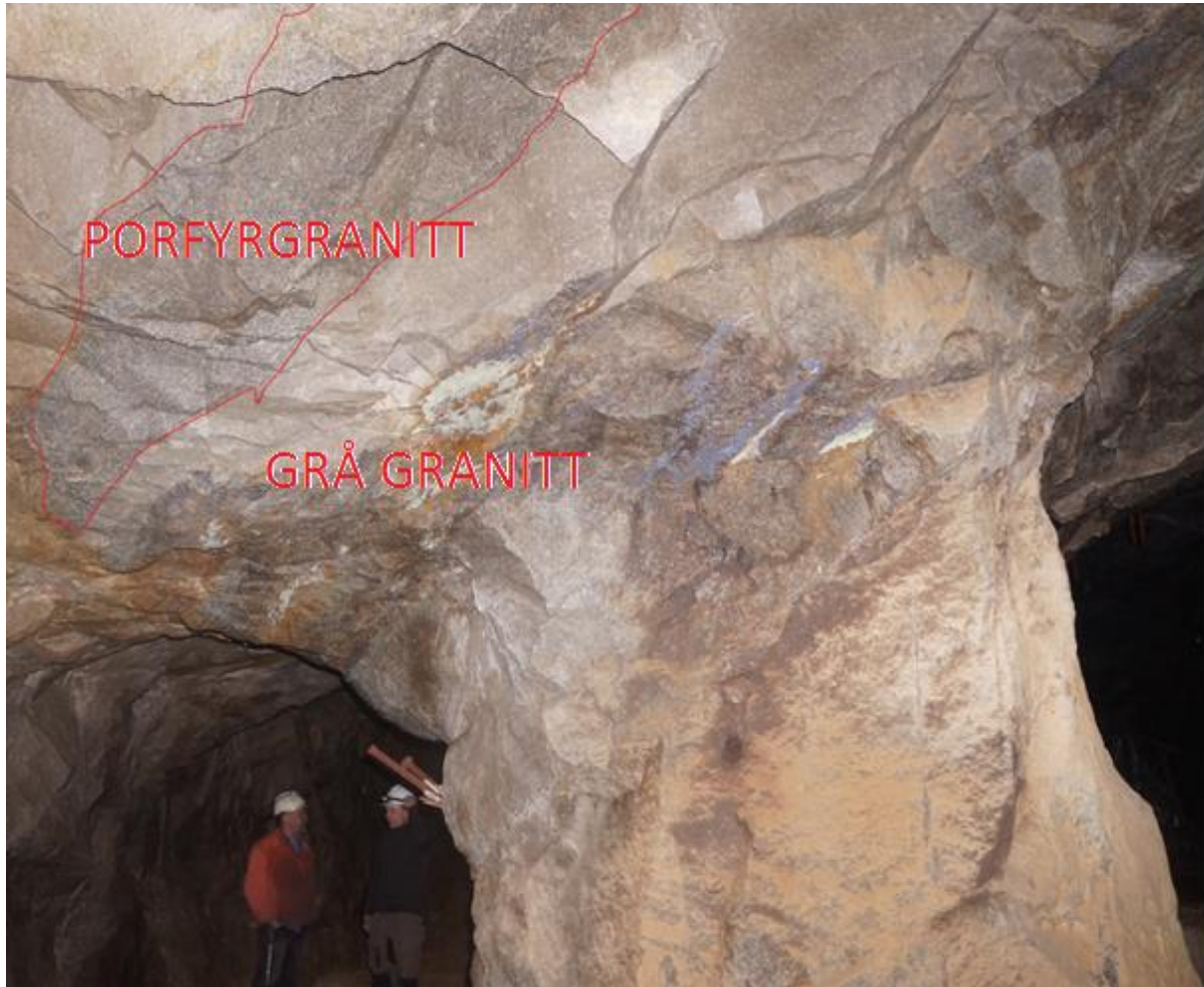
Figur 24 Underjord i Knaben 2 med grovkornet molybdenitt i foliasjonsplanet til grå granitt ved strossen. Xenolitt av porfyrganitt i grå granitt er markert med rødt.
