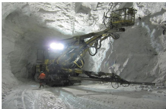
Figur 5.1-9 Boring av stross
