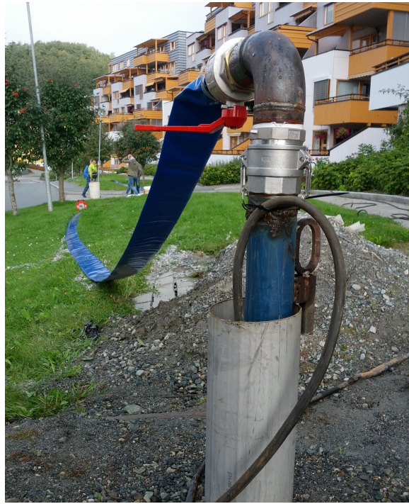
Figur 4.3: Prøvepumping av ny produksjonsbrønn. Her fra brønn B1, med plastslangen som sender vannet ned i brønn B3 (Foto: M. Førde).
