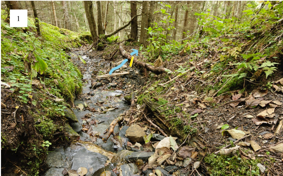
Figur 5.25: Oversvømmelse av bekkeløp som har ført til vann "på ville veier" (vannveien er markert med blå pil og nummert som vannvei 1). Bildet er tatt mot nordøst (Foto: Wenzel Prokosch, 11.09.2014).
