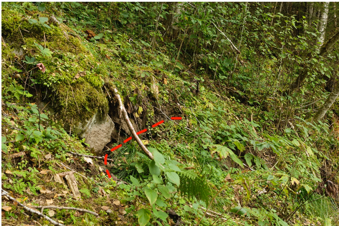
Figur 5.9: Sprekk (rødstiplet linje) i løsmassene ovenfor bruddkanten (Foto: Wenzel Prokosch, 11.09.2014).
