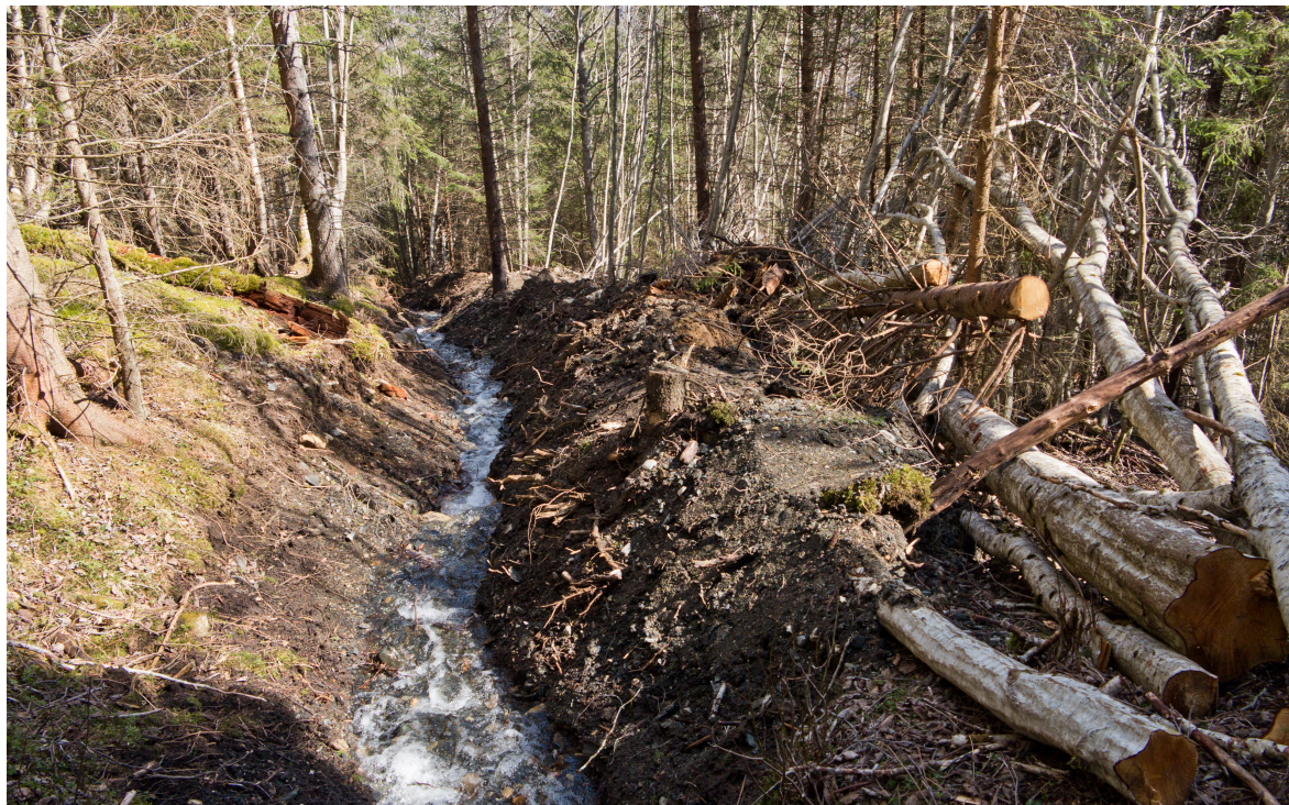
Figur 8.3: Bildet er tatt 26.04.2015 og viser at det er bygget en voll på nedsiden av bekken (Foto: Synne Tveiten, 26.04.2015).
