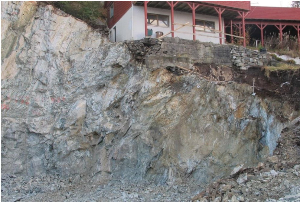
Figur 6.5. Vestre påhuggsflate til Follidalstunnelen, november 2013. Bunn av tunnelpåhugget befinner seg ca. 8 m under nivået ved denne tiden.
