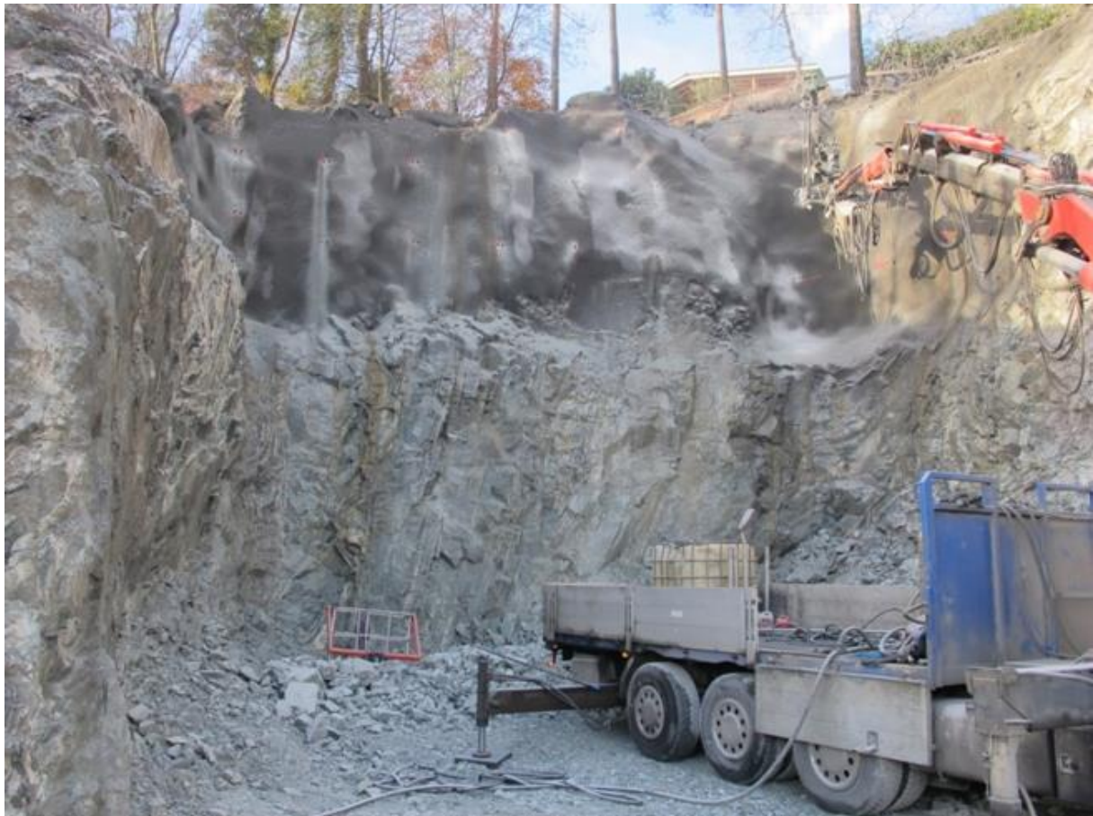
Figur 6.12. Øvre del av østre påhugg i Solheitunnelen øst, november 2013. Tunnelpåhugget er senere etablert like under sprøytebetongen.
