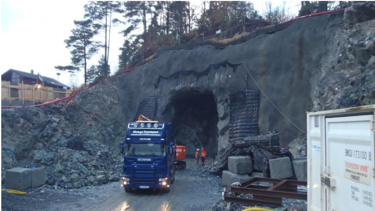
Figur 6.19. Det østre påhugget av Dyrhovdtunnelen, oktober 2013.
