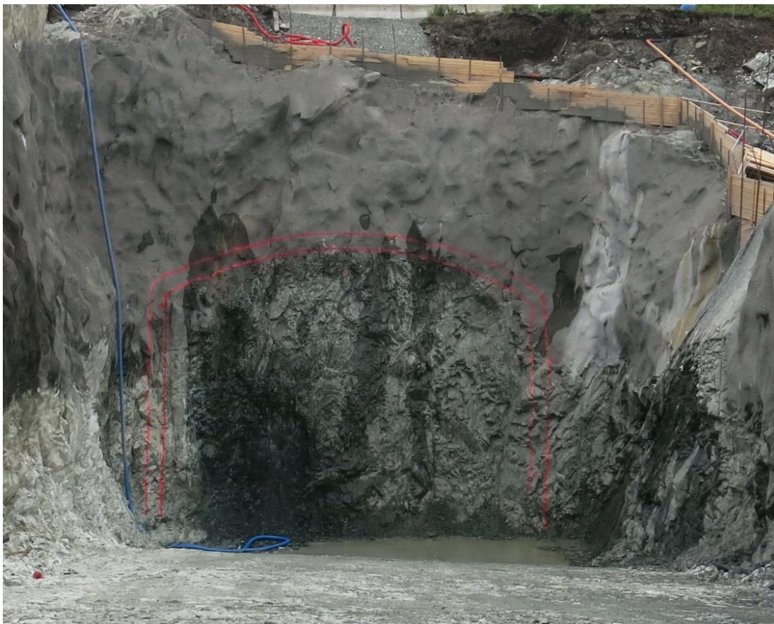
Figur 6.7. Utgangspunktet for østre påhugg av Steinsviktunnelen, mai 2014. Innerste rød strek markerer tunnelpåhugget, mens ytterste markerer første rast med forbolter.
