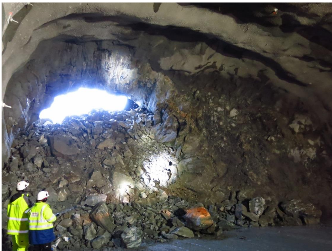
Figur 6.21. Gjennomslag i Dyrhovdtunnelen ved vestre påhugg, januar 2014.
