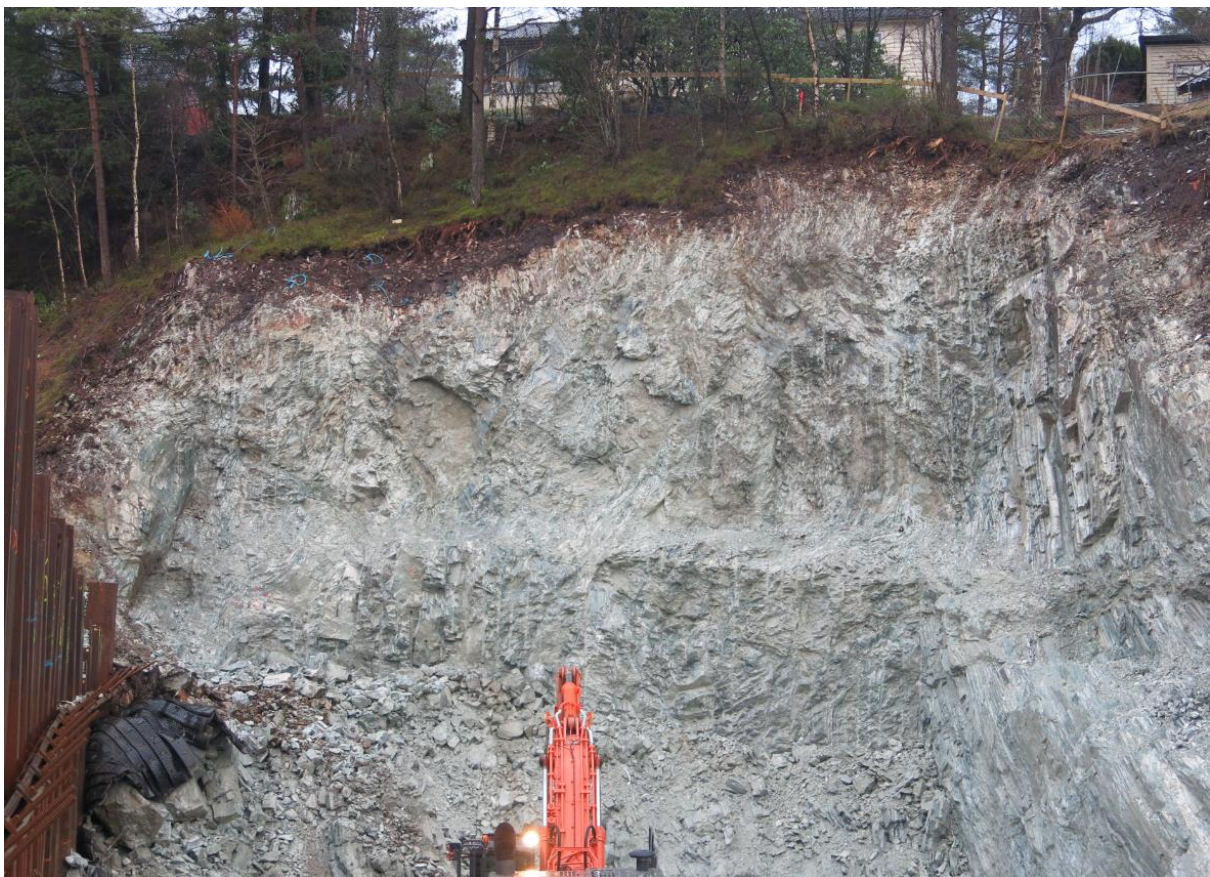
Figur 6.13. Etablering av påhuggsflate mot Solhei øst, februar 2014. Tunnelpånågget er senere etablert like under øverste pall.
