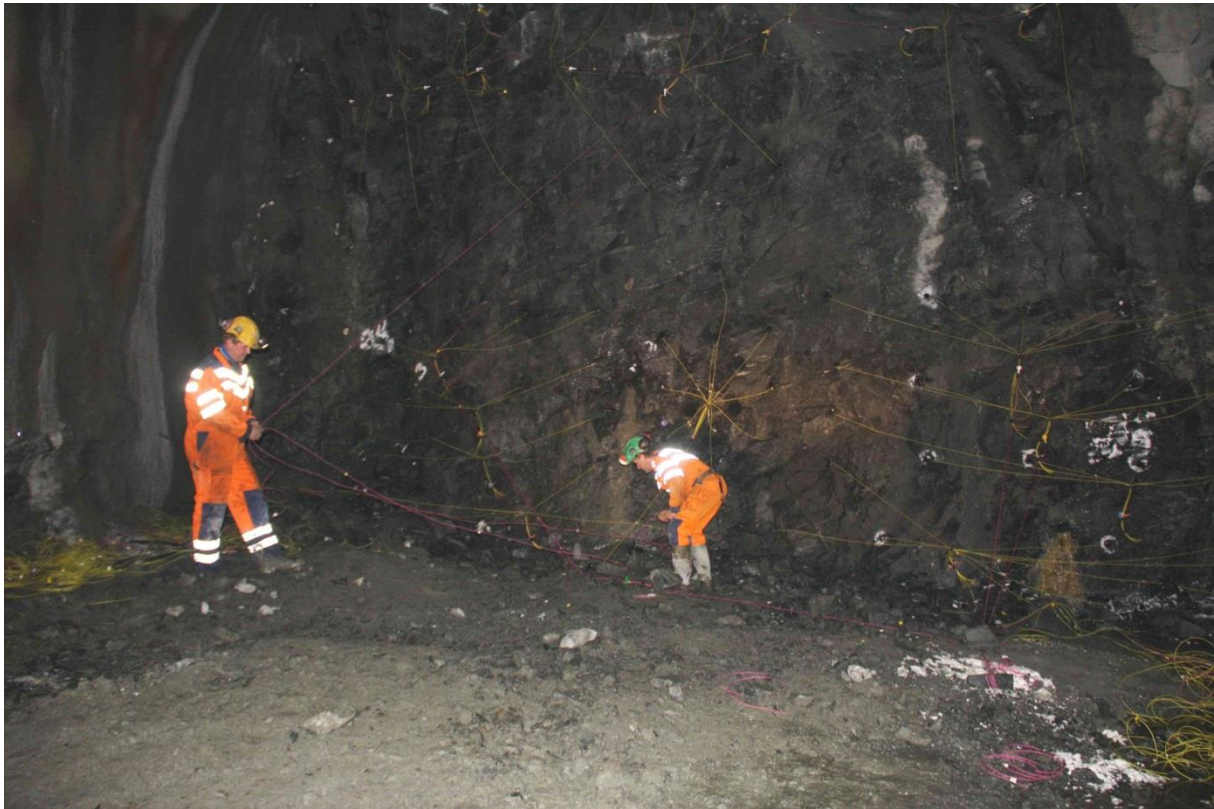
Figur 5.1. Forberedelser av siste salve på Nesttunhaugtunnelen, november 2011. Foto: Bybanen Utbygging.
