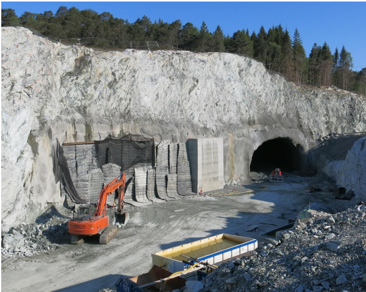
Figur 5.3. De to påhuggene for forlengingen av Ringveg Vest og Knappetunnelen. Bybanen vil passere i bro over påhuggene. Dyrhovdtunnelen befinner seg ca. 500 m til høyre/nordøst for bildet. Foto: Multiconsult.
