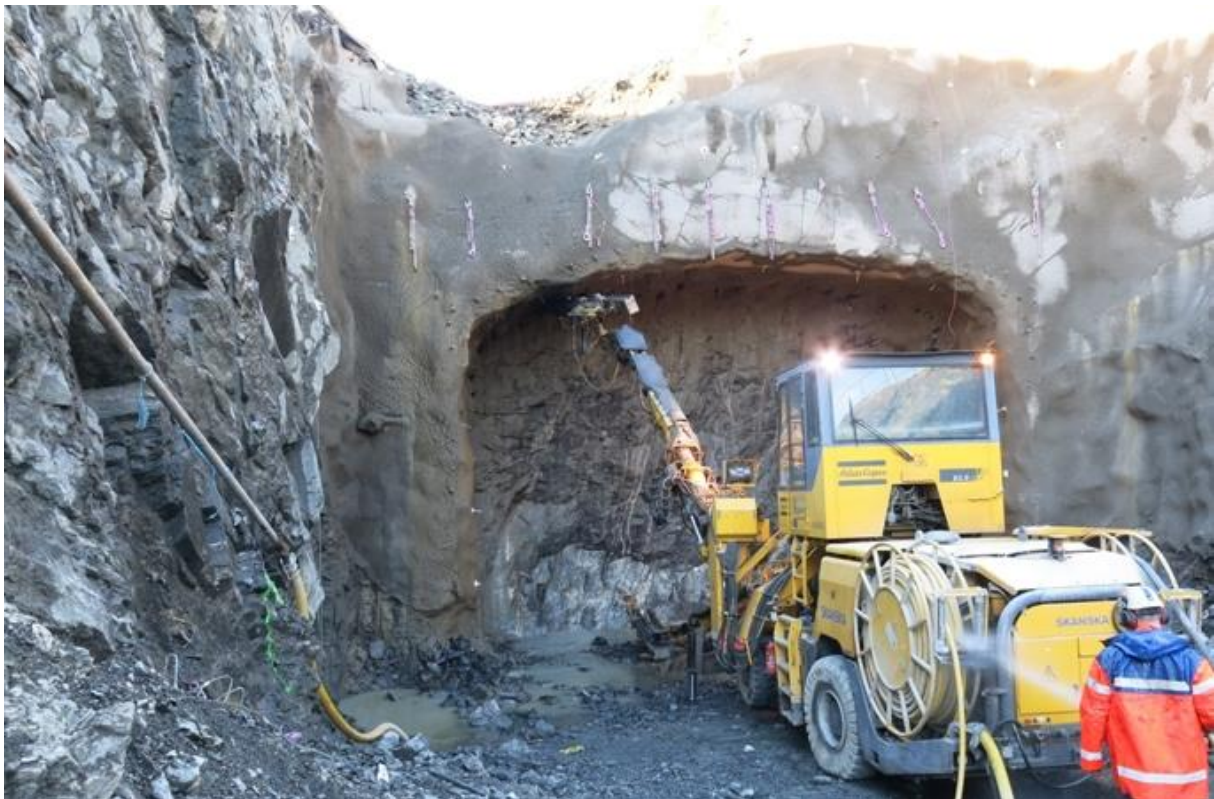
Figur 6.24. Sikring etter første salve ved det østre påhugget, februar 2014.
