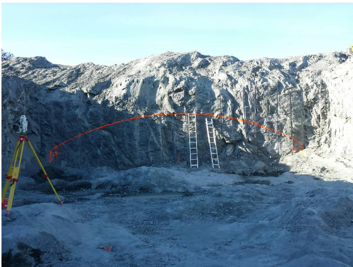
Figur 6.26. Øvre del av søndre påhugg av Fleslandtunnelen, april 2013. Her var det utfordringer knyttet til lav overdekning på kun 3-4 m, og en sleppe som krysser venstre side av hengen.
