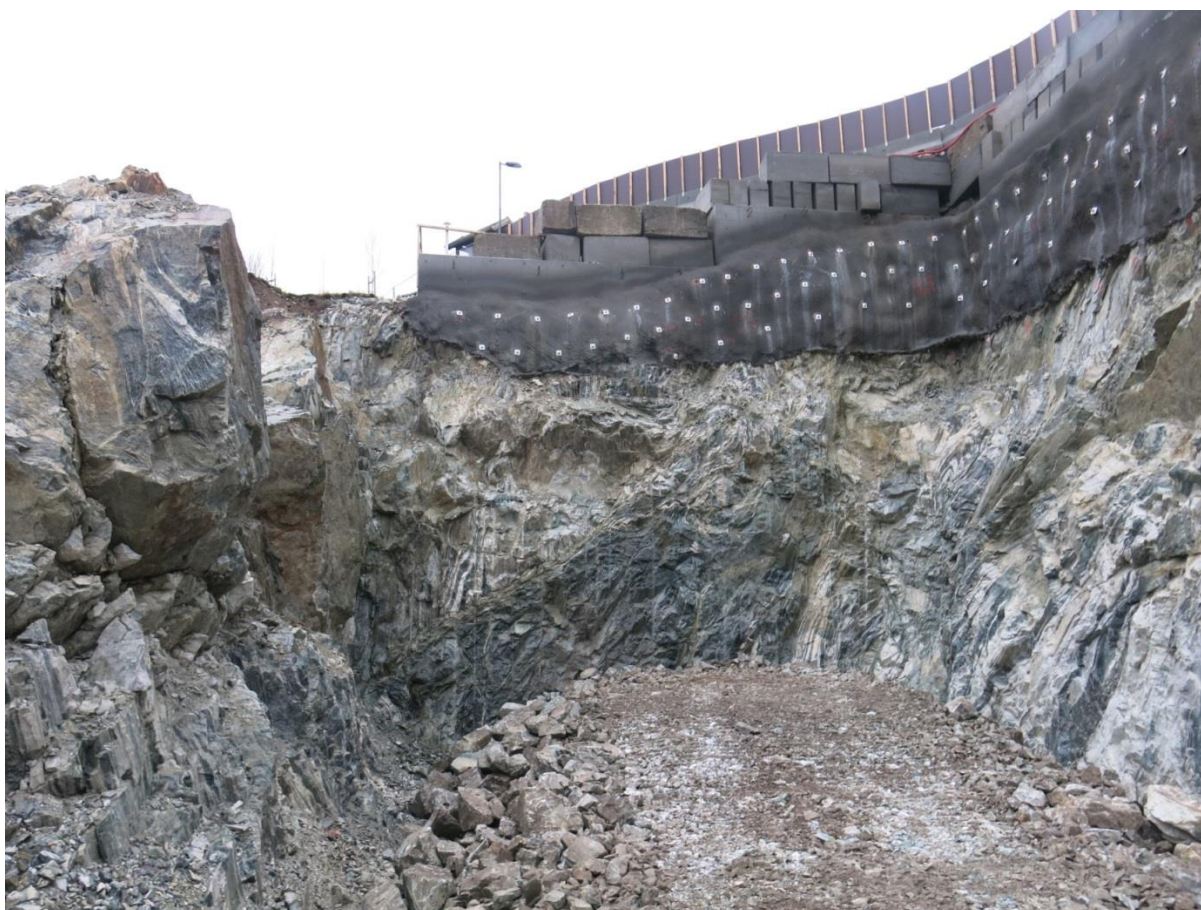
Figur 6.15. Øvre del av påhuggsflate mot Solhei vest, desember 2013. Betongutstøpning er dekket av sprøytebetong og bolter øverst i forskjæring. Tunnelpåhugget er senere etablert ca. 3 m under sprøytebetongen.
