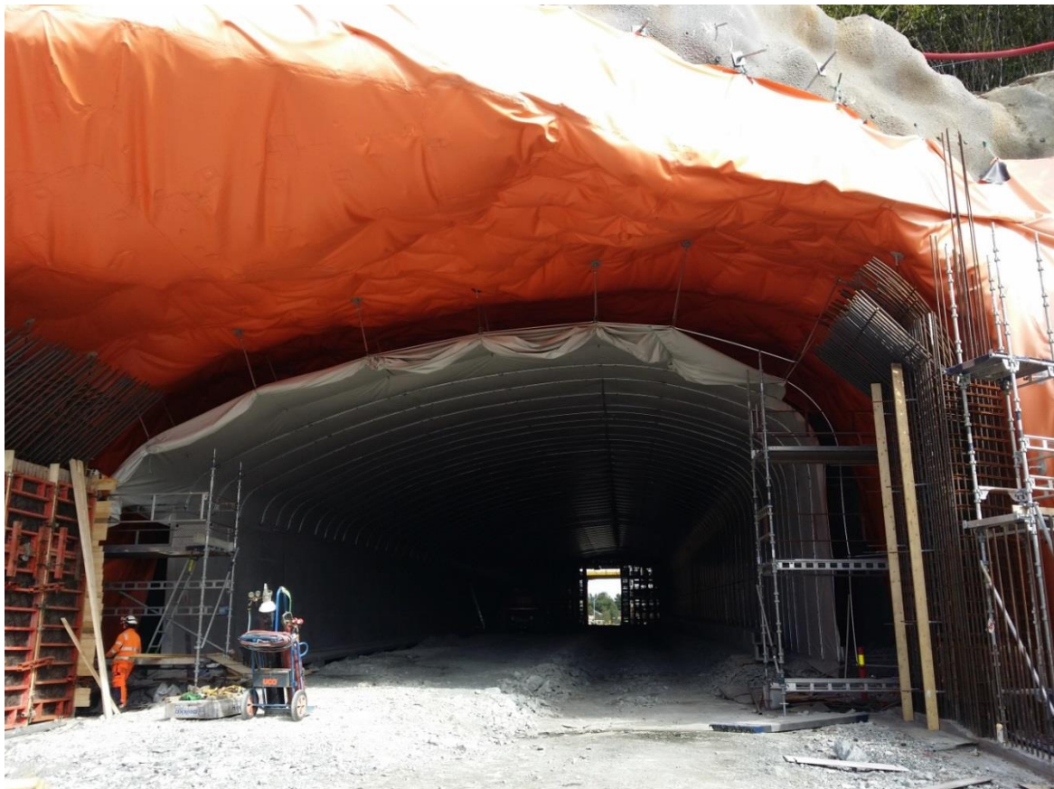
Figur 4.9. Oppsetting av WGT-100 tunnelhvelv i Dyrhovdtunnelen.
