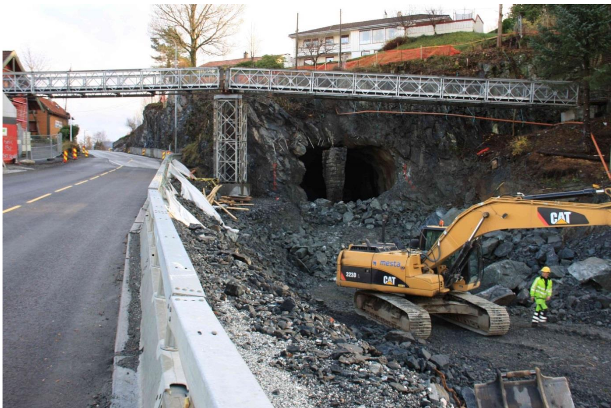
Figur 5.2. Gjennomslag i det sørvestlige påhugget av Skjoldtunnelen, november 2011. Foto: Bybanen Utbygging.
