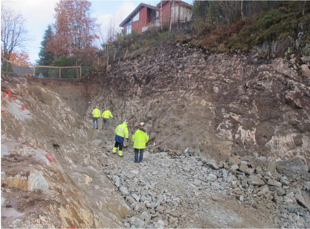
Figur 6.9. Kløft ved påhugg over Steinsviktunnelen vest før etablering av betongplate, desember 2013.
