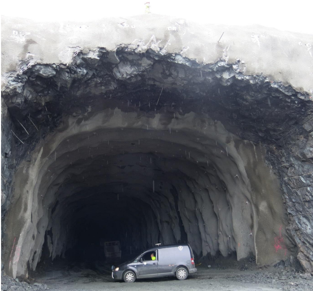
Figur 6.27. Det søndre påhugget før påføring av sprøytebetong og bolter. Bildet er tatt 5. juni 2014, dagen etter at tunnelen fikk gjennomslag.
