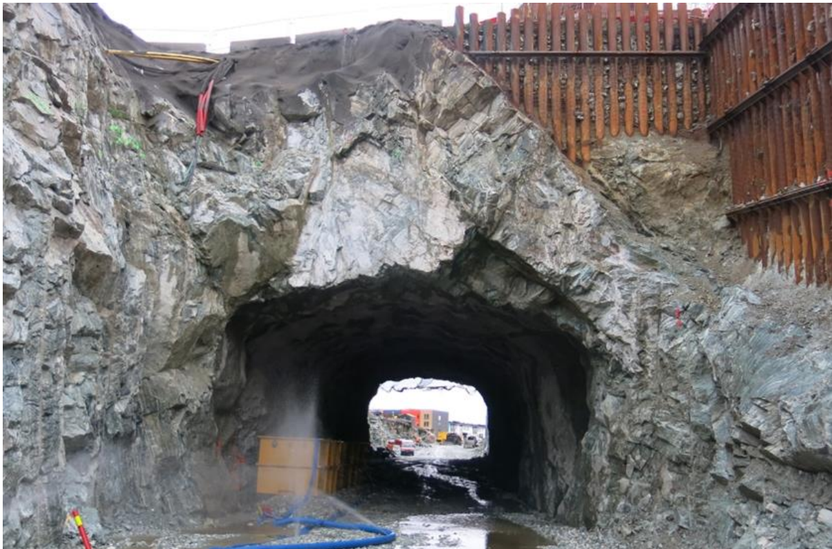
Figur 6.4. «Cut & cover» i Folldalstunnelen, sett mot vestre påhugg, februar 2014.
