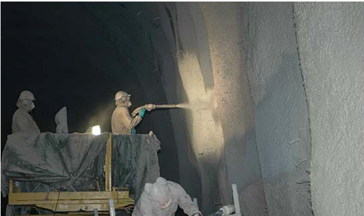
Figur 5.5. Påføring av sprøytbar membran i Gevingåstunnelen. Foto: Petter Solbakken, Jernbaneverket.
