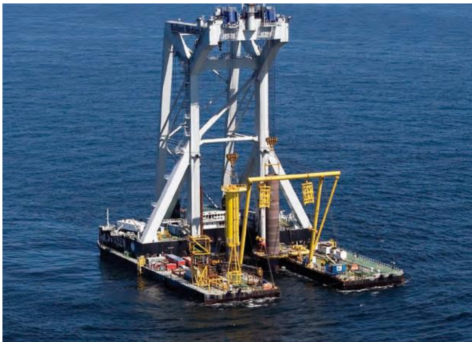
Figur 4 Tungløft-skipet Svanen installerer en monopel på vindparken Butendiek i tysk sjø (BallastNedam, 2014)
