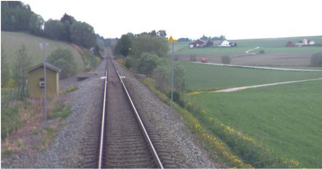
Figur 39: Skatval detektorstasjon ved km 43.340 på Nordlandsbanen
