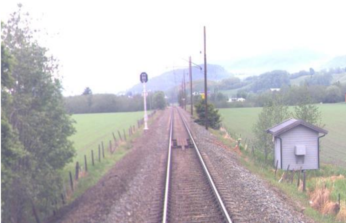
Figur 40: Høyset detektorstasjon ved km 518.46 på Dovrebanen
