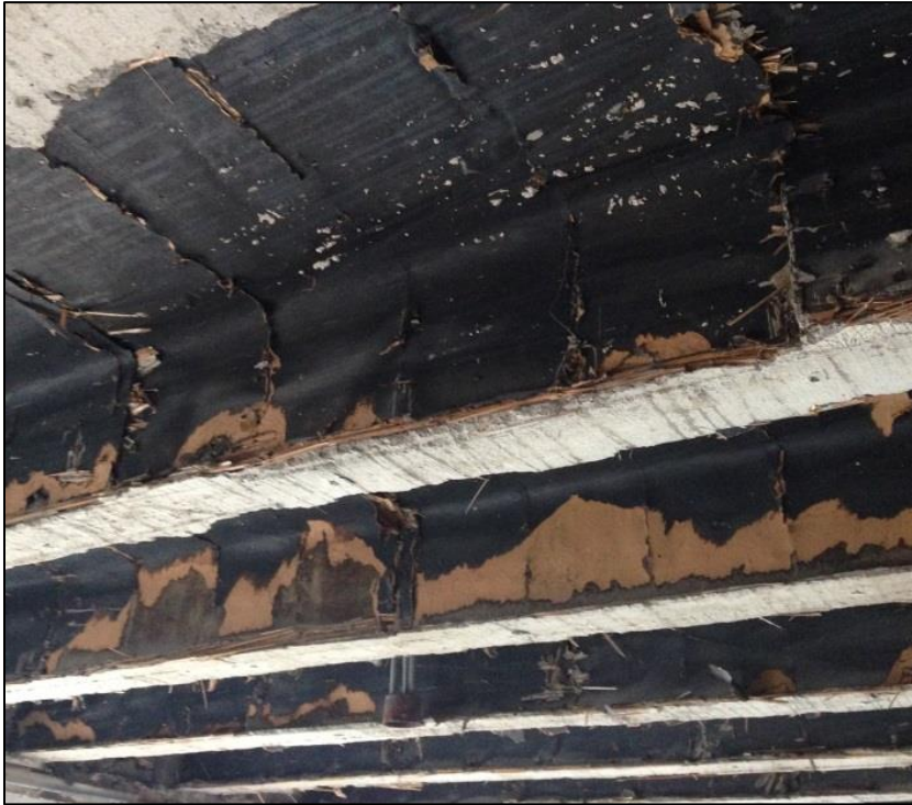
Figur 17 Ribbedekke i 1930-bygget.
