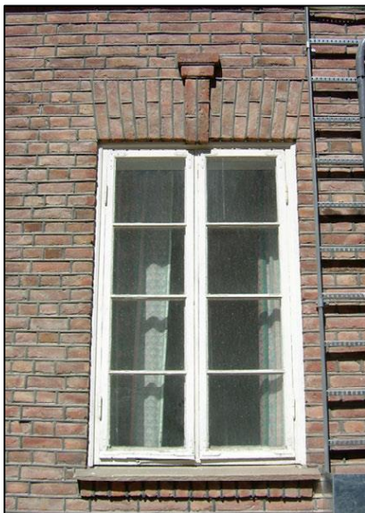
Figur 12 Vindu i 1930-bygget. Foto: Leif Maliks, Forsvarsbygg
