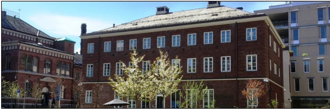
Figur 11 Fasade mot park etter rehabilitering. Foto hentet fra: Sykehusbygg (2015)
