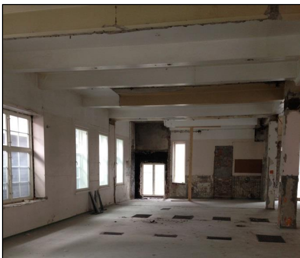
Figur 15 1930-bygget under riving. Foto: Sindre Ekli
