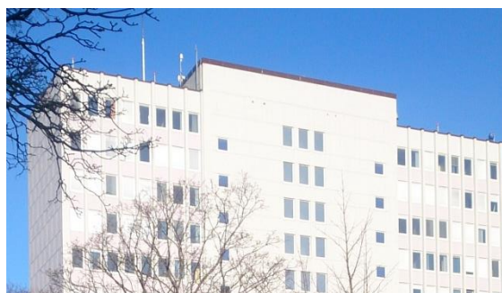
Figur 18: Taket på sentralbygg 2 fra bakken.
