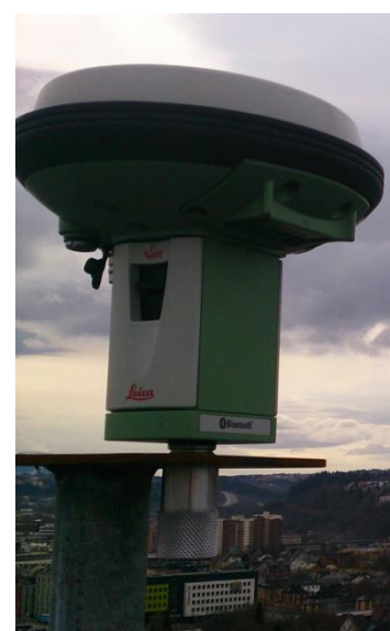
Figur 24: Montering av antenne på søyla.
