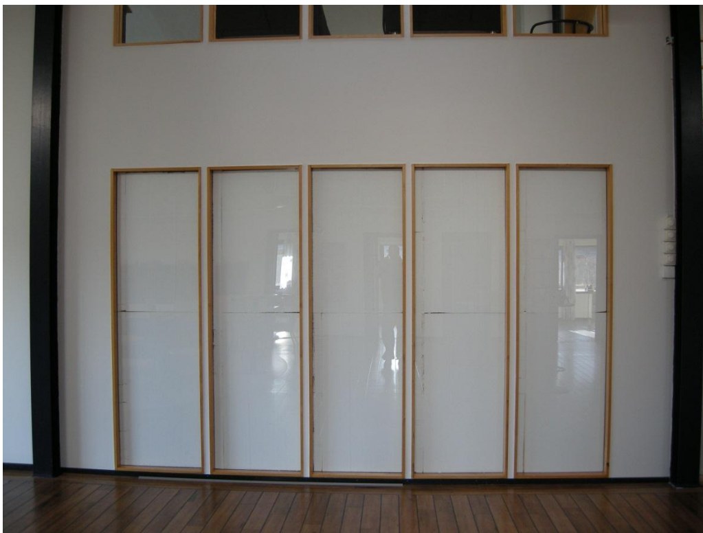
Figur 24: Vegg bestående av vindusruter etterisolert med isopor.
