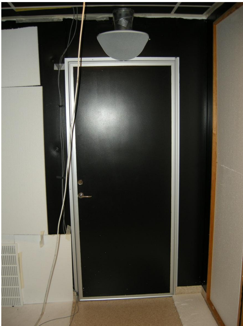
Figur 33: Airshower veggventil montert i forsøksrommet over dør.
