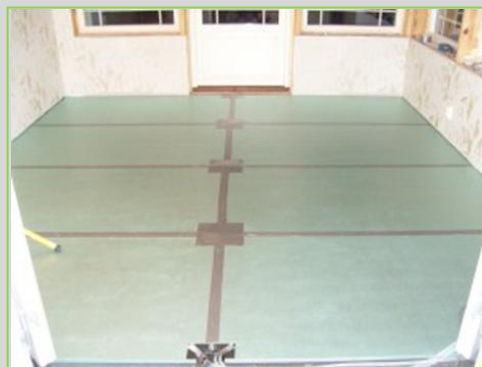
Nor Technologies' nye golvvarmepanel. Hurtig regulering og rimelig investeringskostnad
