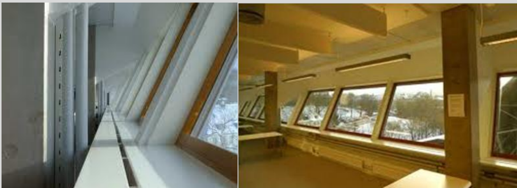
FIGUR 11 OPPSUMMERT NØKKELINFO OM BELLONAHUSET EKSPONERTE RØYRFØRINGAR OG RADIATORAR UNDER KVART VINDAUGE. (BELLONA, 2011)
