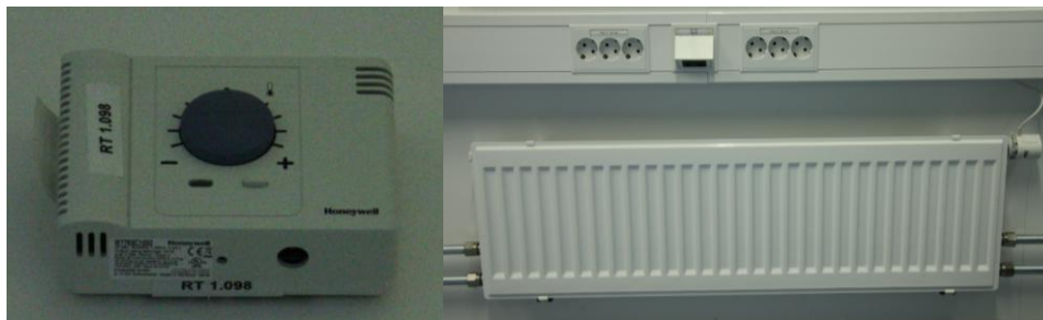
Figur 14, Reguleringspanel for individuell regulering av temperatur på cellekontorer (t.v.) og radiator med elektronisk reguleringsventil (t.h.)
