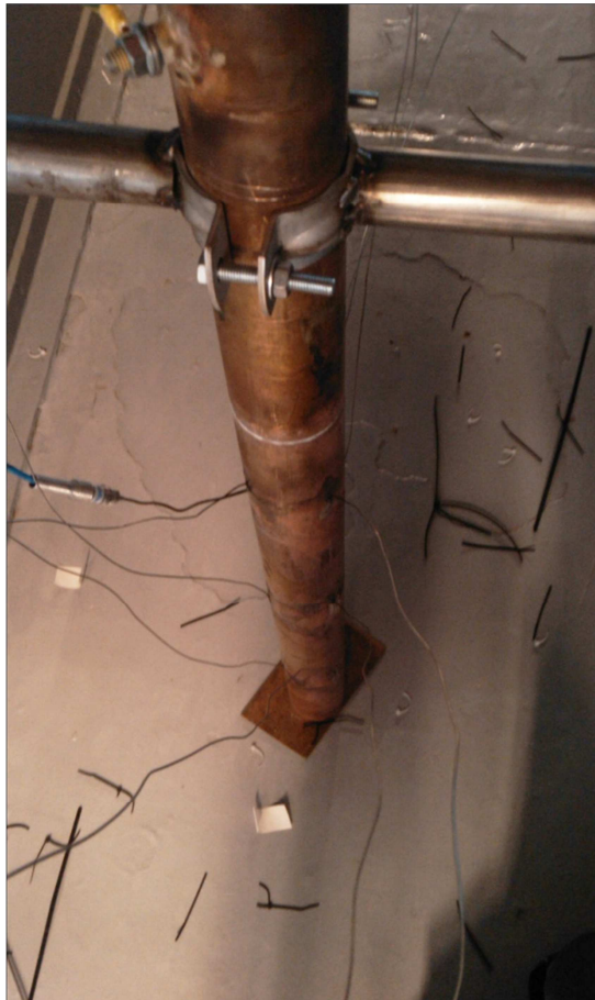
Figur 7-1, Montering av røret i vannrenna
