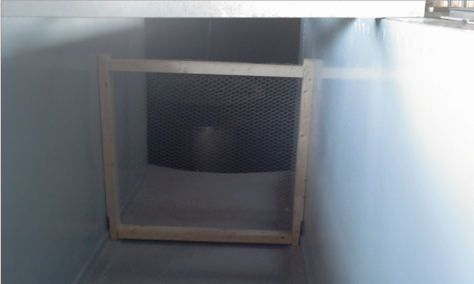
Figur 4-4, Gitter ved utløp av vannrenne
