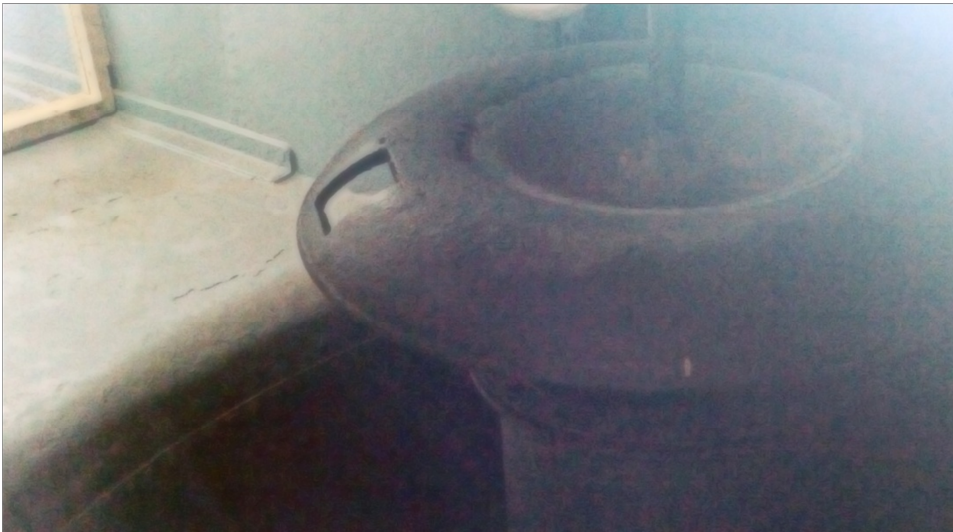
Figur 9-2, Overløp ved utløpet av vannrenna
