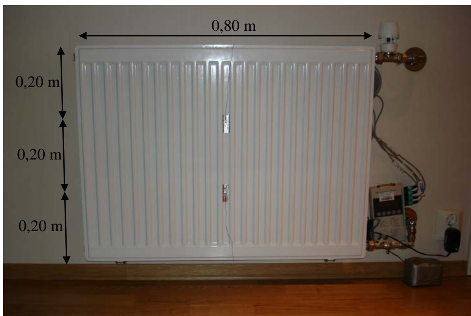
Figur 4. Plassering av termoelementer på radiatoroverflaten.
