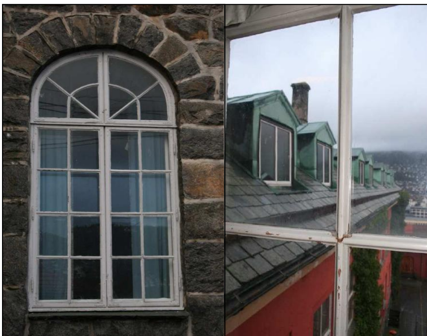
Figur 4.8: Opprinnelige vinduer (t.v) og utskiftede takarker med vindu (t.h.)
