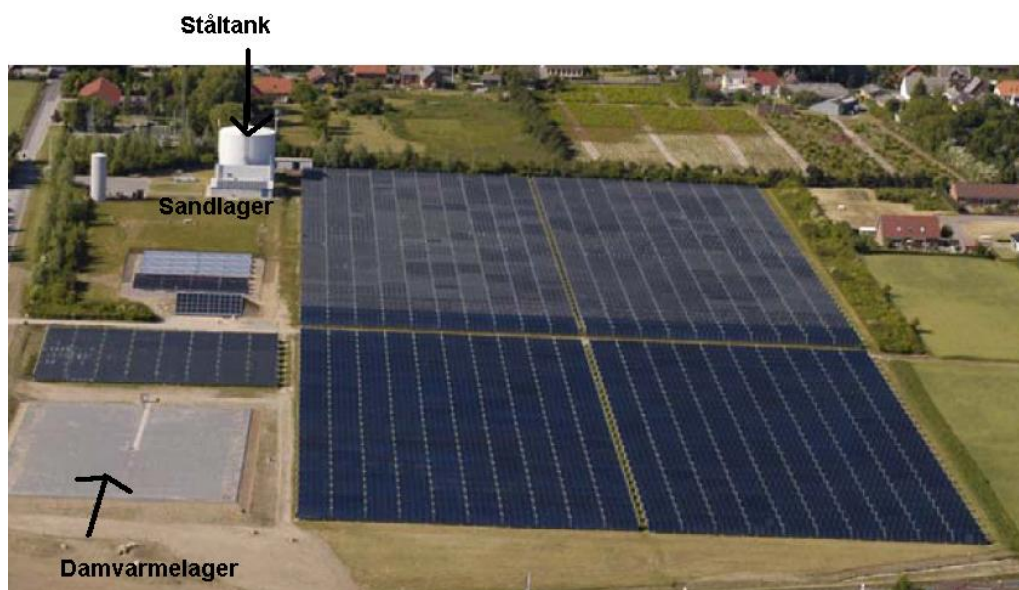
Figur 24: Marstal er eit stort solvarmeanlegg i Danmark for bruk i fjernvarme. Marstal tar bruk av både damvarmelager (10 000 m 3 ), ståltank (2 100 m 3 ), og sandlager (3 500 m 3 ) [Jensen, Ø., S. et al., 2005].
