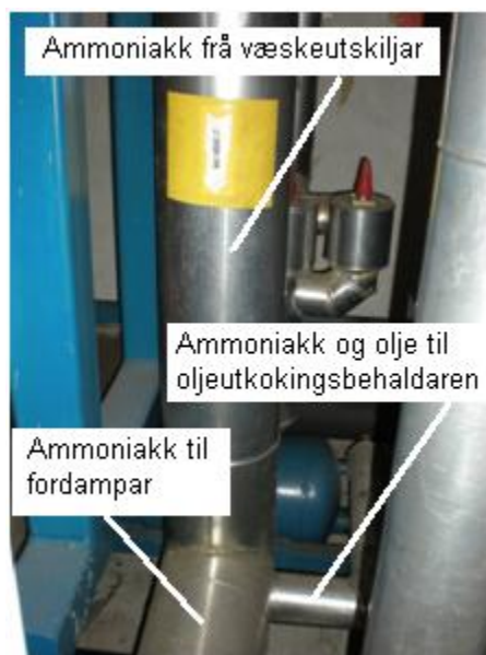
Figur 47 Delstraum av ammoniakk ned til oljeutkokingsbeholdaren
