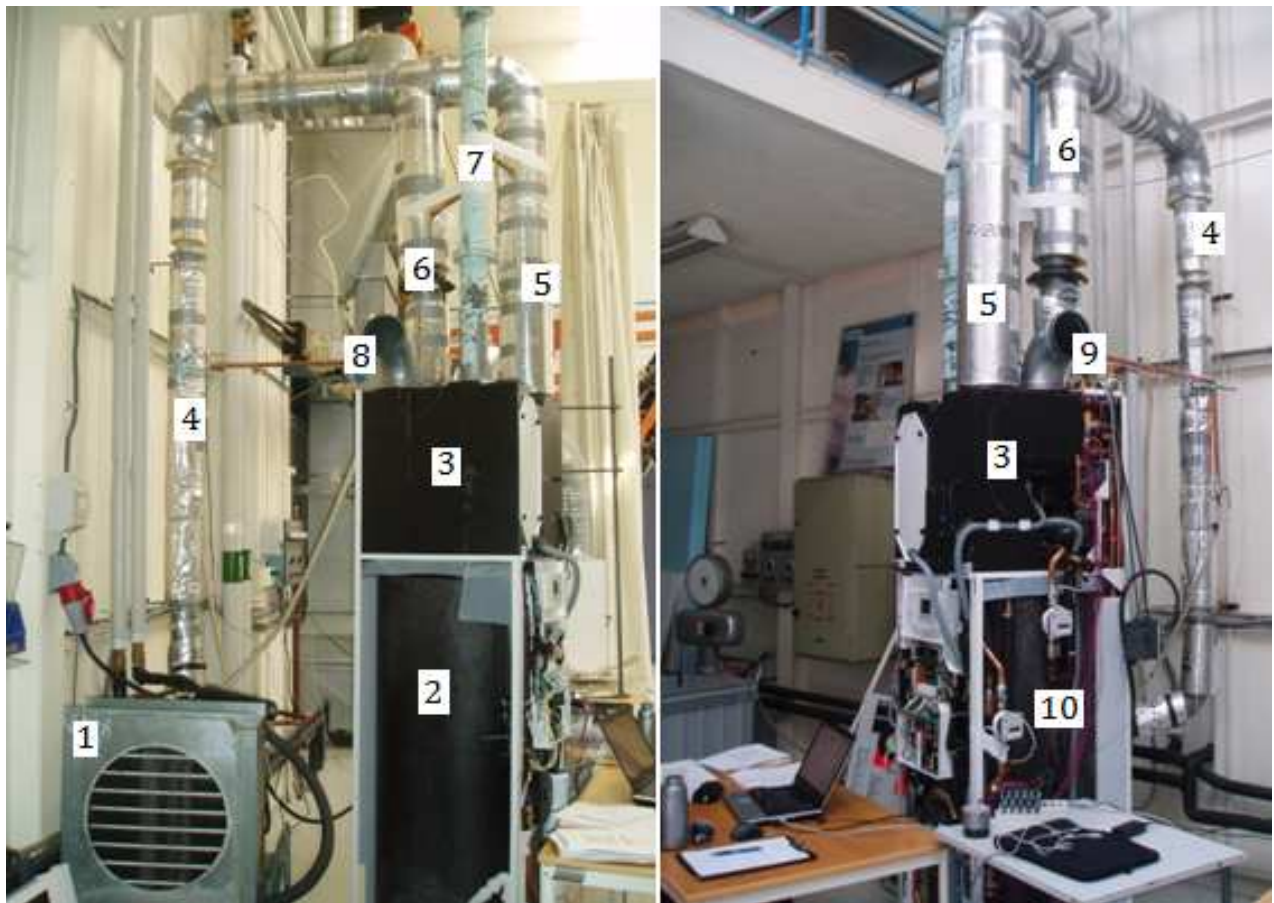
Figur 3.2 Kompaktaggregatet med tilkoblet måleutstyr og ventilasjonssystem i laboratoriet.
