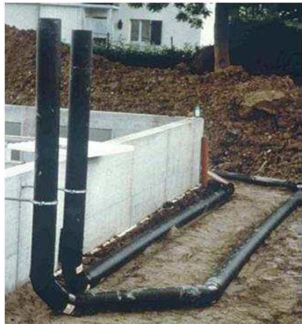
Figur 4.1 Jordvarmeveksler lagt rundt bygningen. (Viessmann, 2006a)
