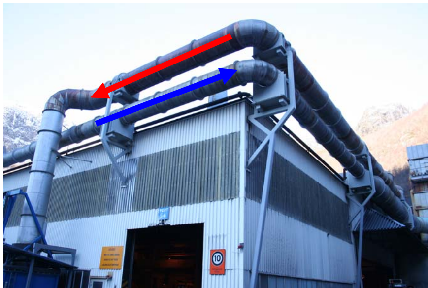
Figur 15: Avgasskanaler til og fra forvarmekammeret
