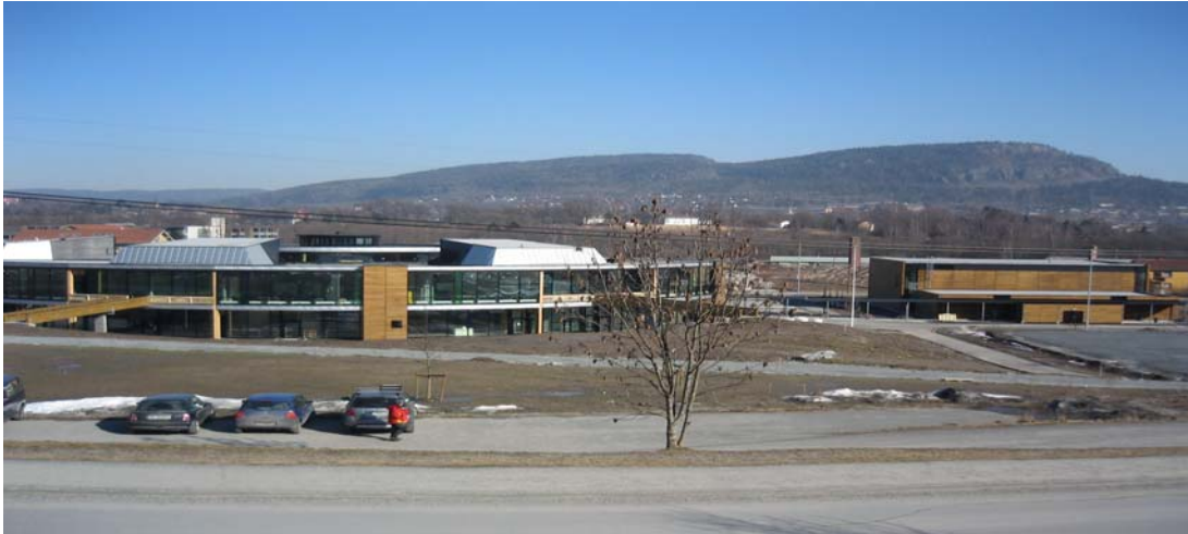
Bilde 6-1 Skolebygningen og den tilhørende idrettshallens fasade mot nordøst
