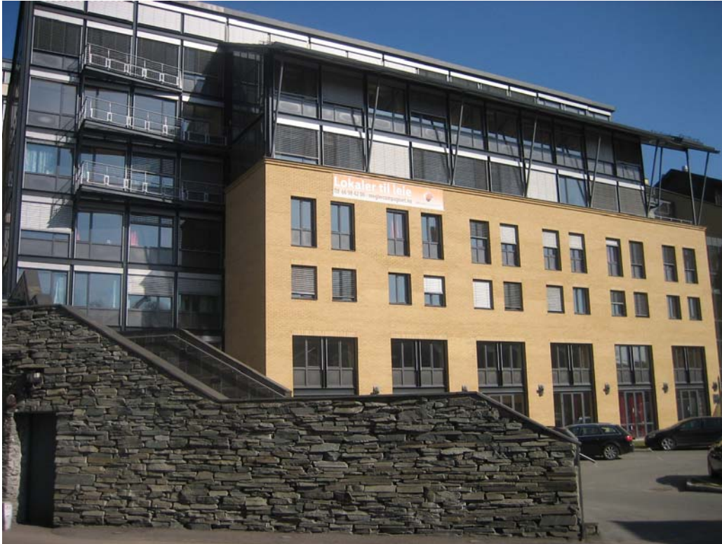
Bilde 7-1 Sørfasaden av kontorbygningen Lilleakerveien 2C
