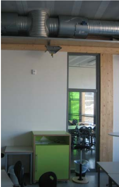
Bilde 6-9 Bilde tatt innenfra i basene. Viser temperaturmåler, lyskilde og hylle under ventilasjonssjakter
