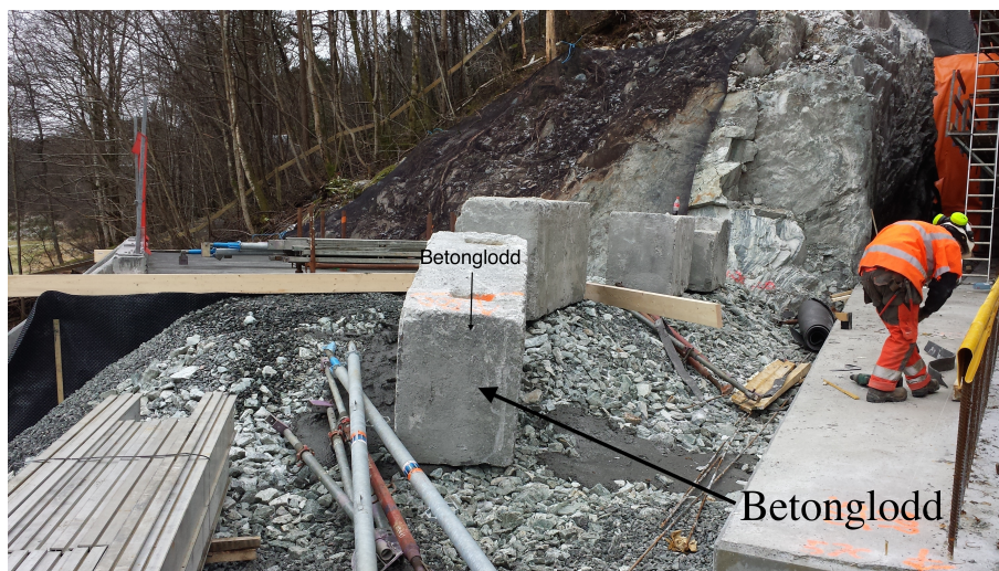
Figur 3.47: Betonglodd (her ikke innfestet)
