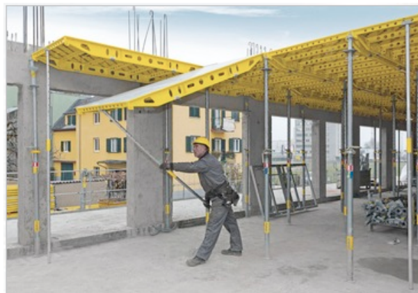
(b) Montering av systemkassett [84]
