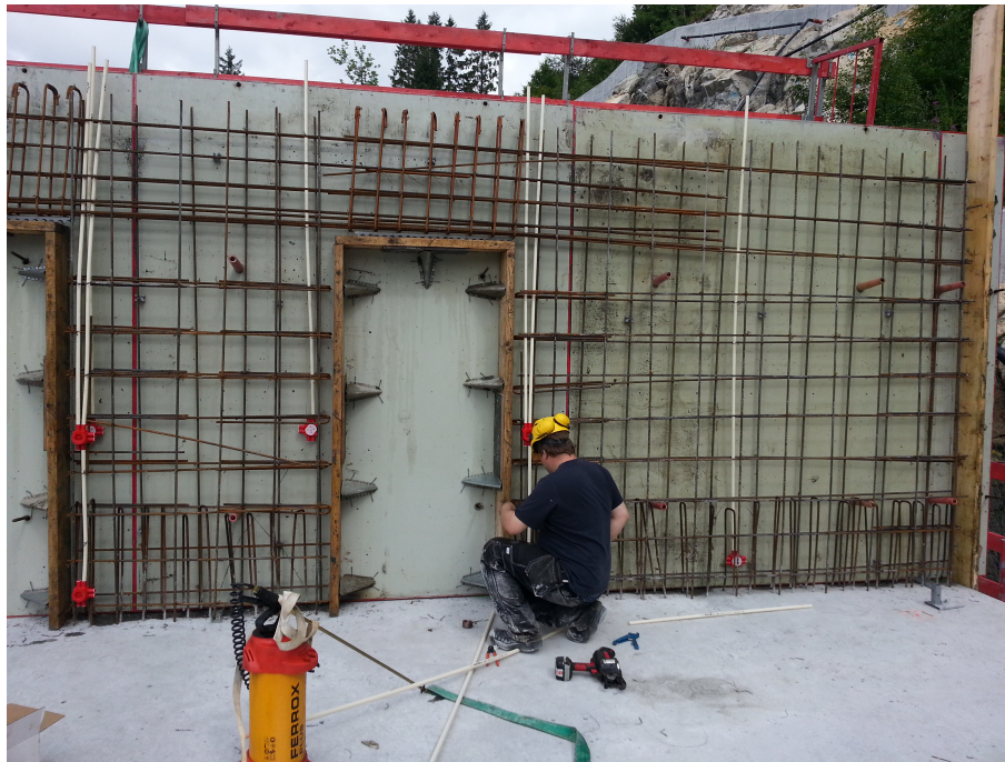
Figur 3.54: Trekkerør parallelt med armering)
