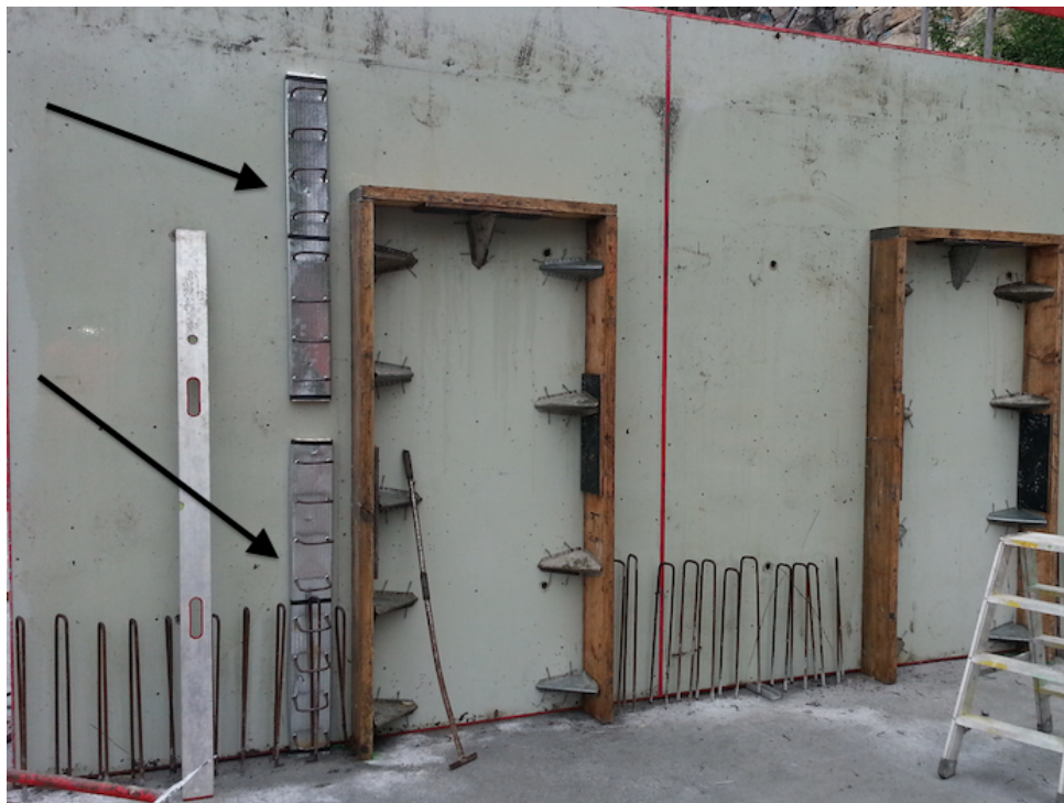
Figur 3.65: Skjøtearmeringskassett sett fra innsiden av vegg
