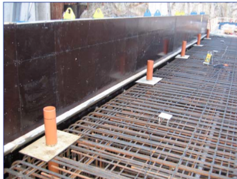
Figur 3.77: Klargjorte fyllingspunkter for et tykt dekke [87]
