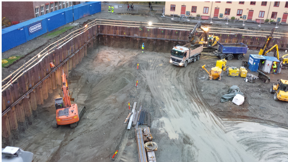
Figur 2.38: Utgraving med formål at stag kan bores fra byggegrop
