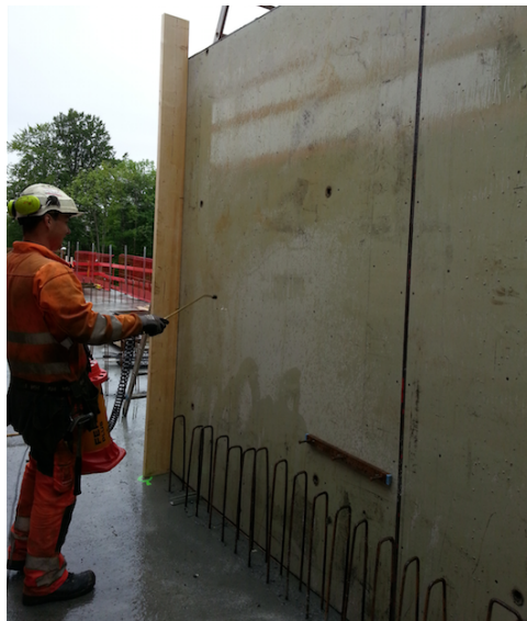
Figur 3.52: Påføring av forskalingsolje
