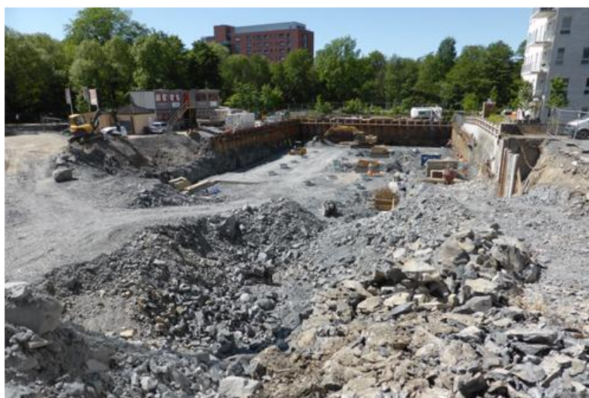
Figur 2.33: Adkomst til spuntet byggegrop [59]
