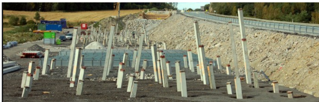
Figur 2.25: Nedrammede betongpeler [44]
