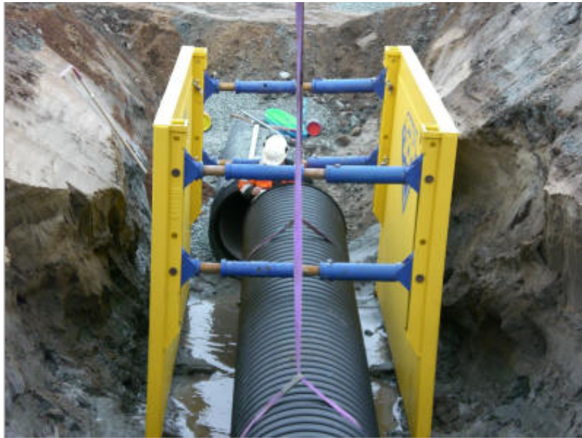
Figur 2.40: Bruk av grøftekasse [64]
