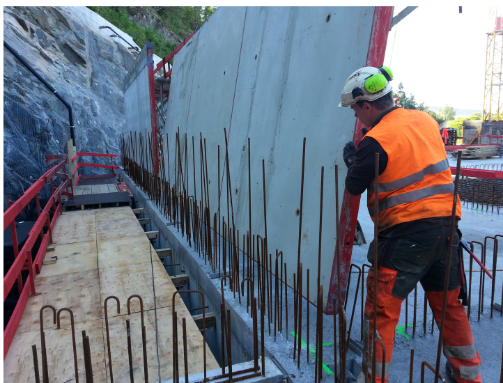
Figur 3.49: Enkling av en yttervegg i 2. etasje
