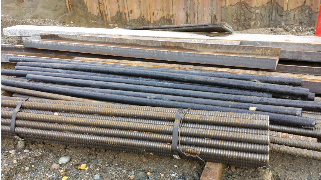
Figur 2.22: Gjengede stålstag til forankring av spunt
