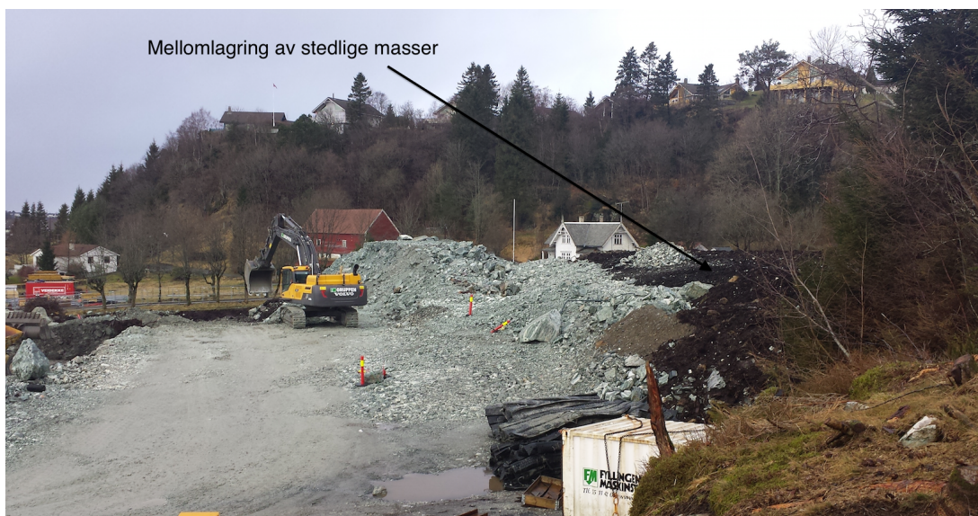
Figur 2.31: Mellomlagring av stedlige masser
