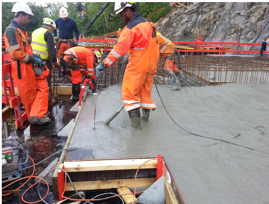
Figur 3.76: Betongarbeider som vibrerer betongen og samtidig sjekker dekkets tykkelse
