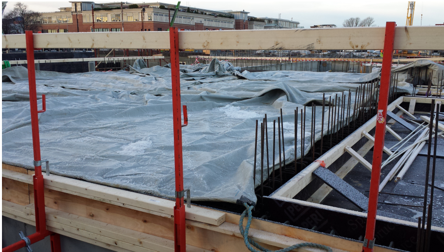
Figur 3.74: Tildekking med presenning
