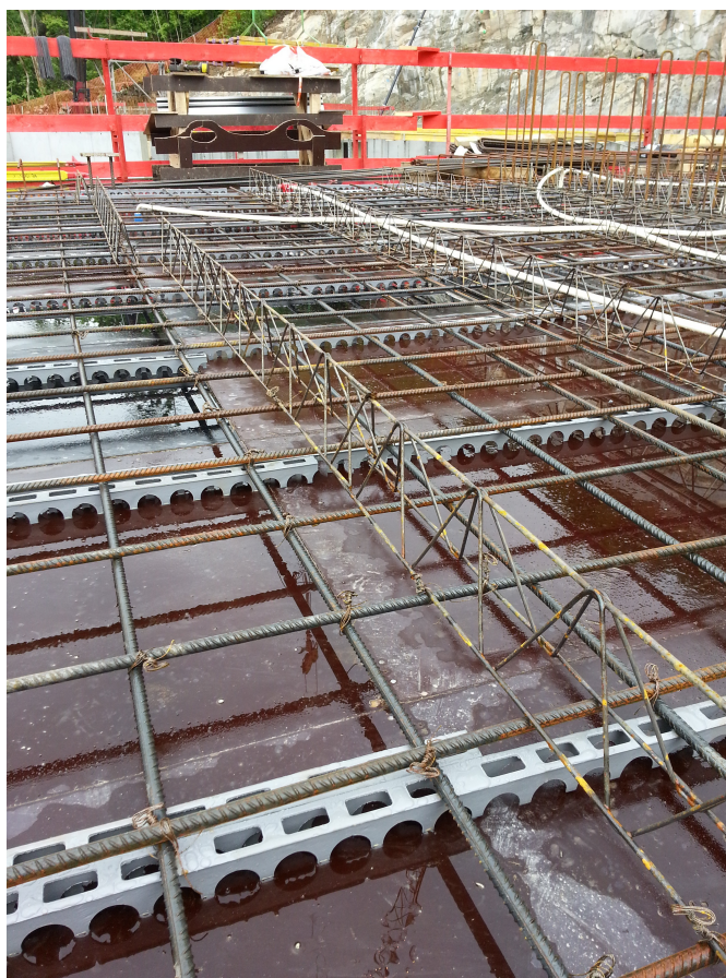
Figur 3.28: Rette avstandsholdere brukt på dekke
