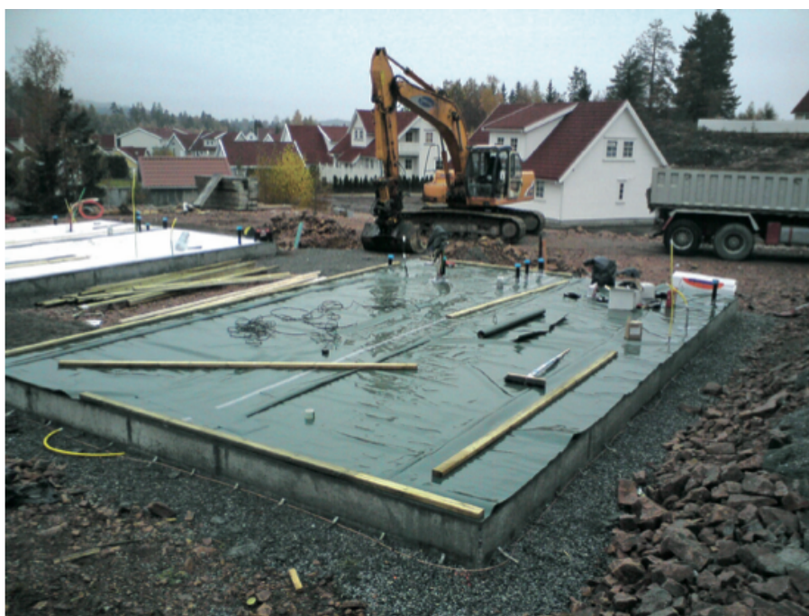
Figur 2.4: Fundament med radonsperre [26]
