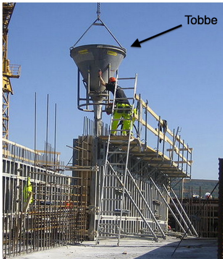
Figur 3.38: Fylling av formen med bruk av tobbe
