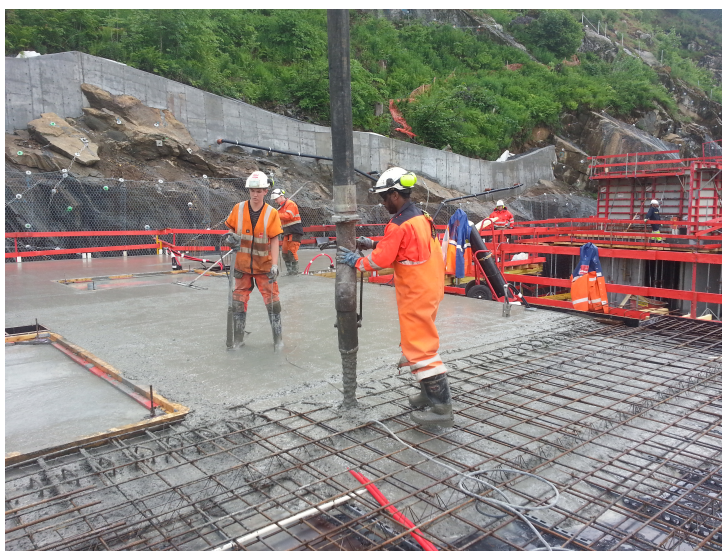
Figur 3.37: Utstøping med betongpumpe
