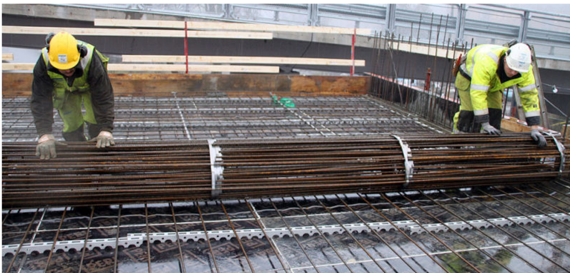
Figur 3.18: Utlegging av rullearming [95]
