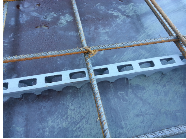
(b) Utlagte armeringskinner på en dekkeforsikling av finér
