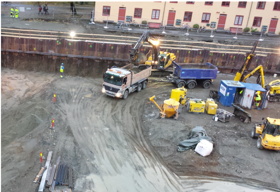
Figur 2.37: Lasting av lastebil med tilhenger, på likt nivå
