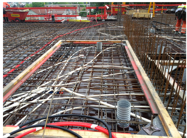
(b) Korrugerte rør i dekke
