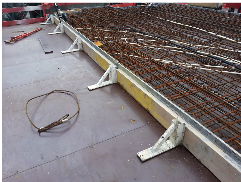
Figur 3.8: Oppstøtting av dekkesteng med AW-vinkel
