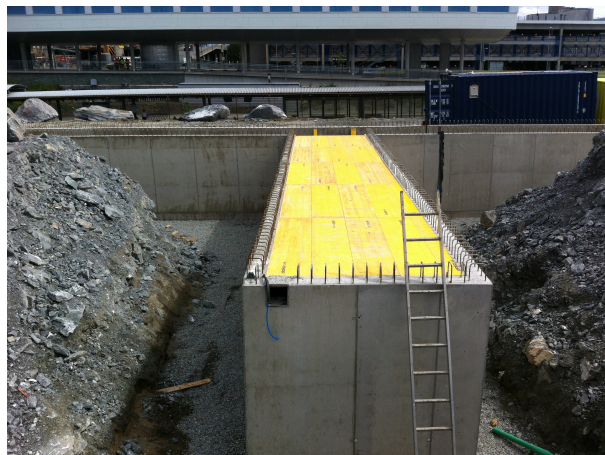
(b) Kjellervegger i byggegrop
