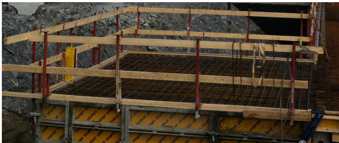
Figur 3.81: En metode for å montere gjerde langs dekkekant
