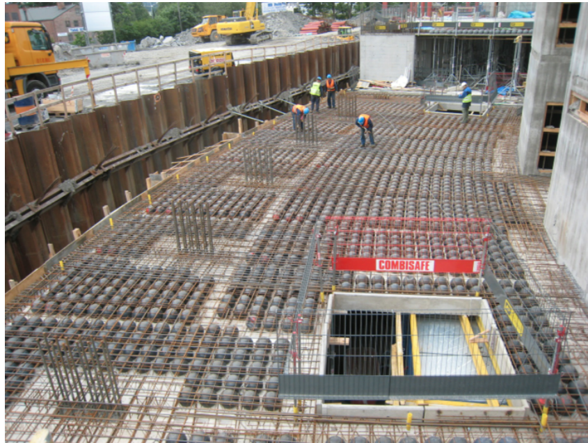
Figur 3.85: Dekke som utføres med bubbledeck [127]
