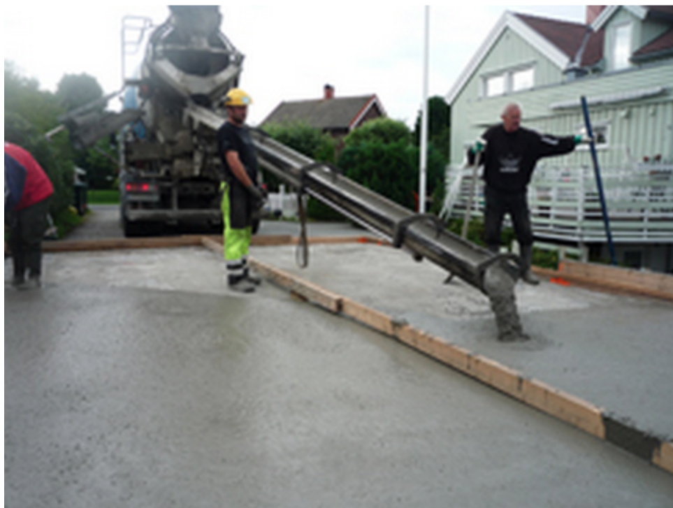
Figur 3.35: Betongbil med renne [109]
