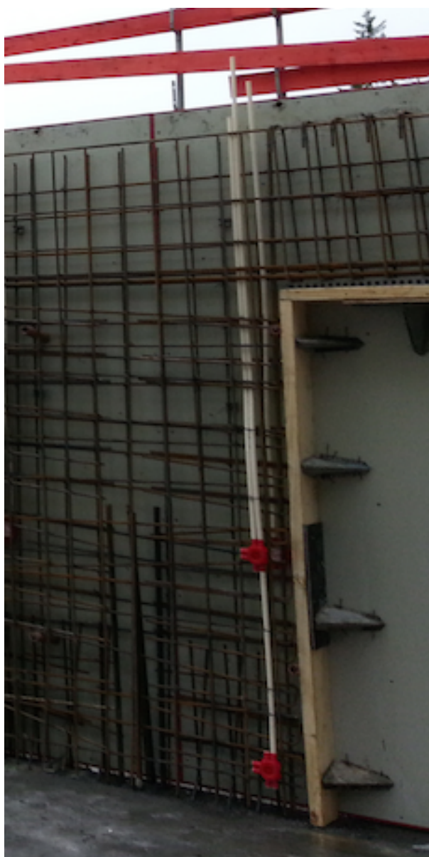
Figur 3.41: Trekkerør i vegg
