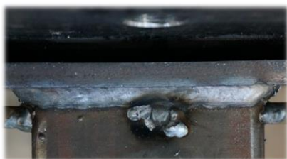
Figur 9.23: Bildet viser avstanden mellom endeplaten og bakplaten ved 160kg.
