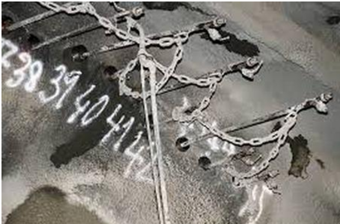
Figur 5-14: Forankring av injeksjonshullene. (Seehusen, 2013)
