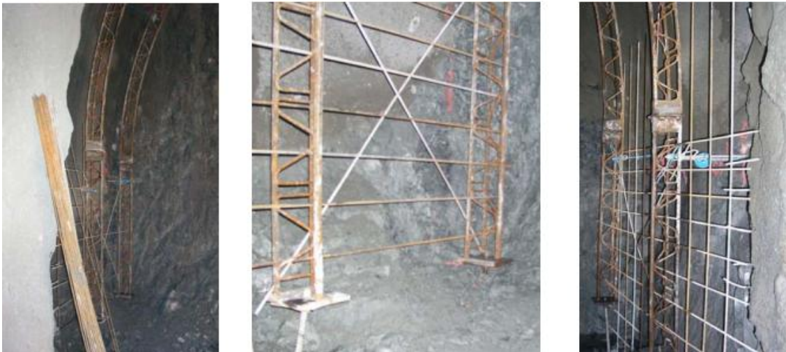
Figur 5-21: Pantex gitterbuer T-baneringen del II, Oslo. (HWE, 2014)
