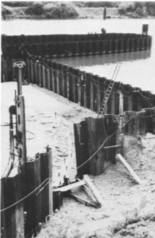
Figur 5-36: Boring og vertikal installasjon av fryserør. (Jessberger, 1980)
