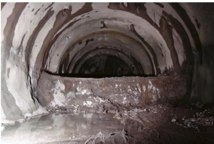
Figur 5-19: Utstrossing av de resterende massene på 3-4 m høyde. (Frogner et al., 2013)
