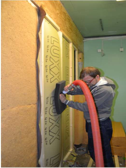
Figur 18: Innblåsing av Zell i veggelementene.
