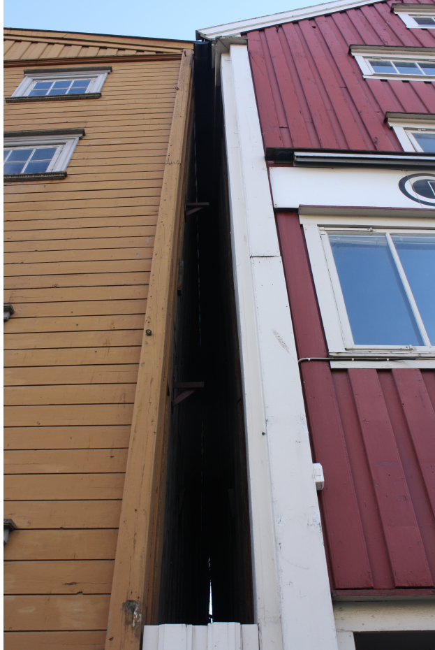
Figur 5.4: Flere steder står bryggene så tett at det vil være umulig å bygge en brannvegg til over tak mellom dem uten å endre den eksisterende konstruksjonen.
