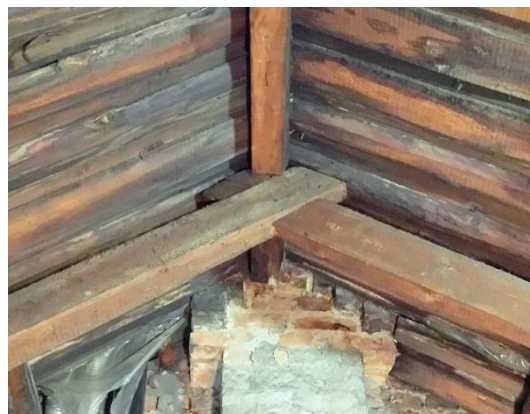
Bilde 3.7 – (6) Hovedbjelkene møtes og er innfelt i hverandre i topp
