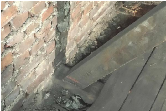
Bilde 3.2 – (1) Knebuikk skråkomponent innfelt i gulvbjelke
