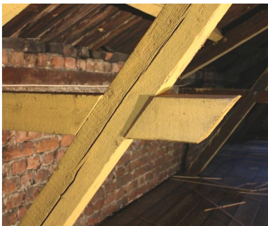
Bilde 3.4 – (3) Kobling mellom skråkomponent og horisontalkomponent i knebukken
