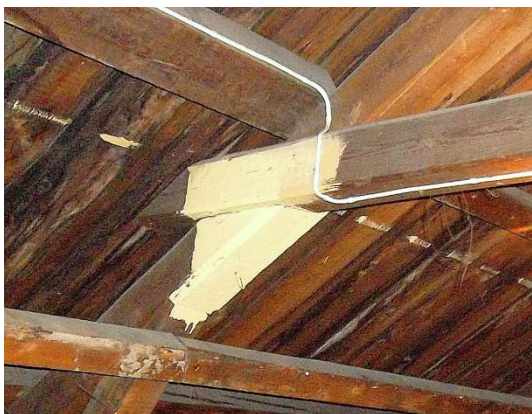
Bilde 3.6 – (5) Hanebjelke og hovedbjelke innfelt i hverandre
