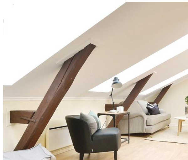
Bilde 1.3 – Skjulte hovedbjelker og tap av takhøyde
