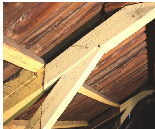
Bilde 3.5 – (4) Skråkomponent fra knebuikk koblet til hovedbjelken i innhugg
