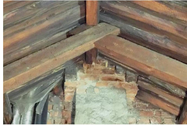
Bilde 3.12 – Kobling mellom hovedbjelkene i topp
