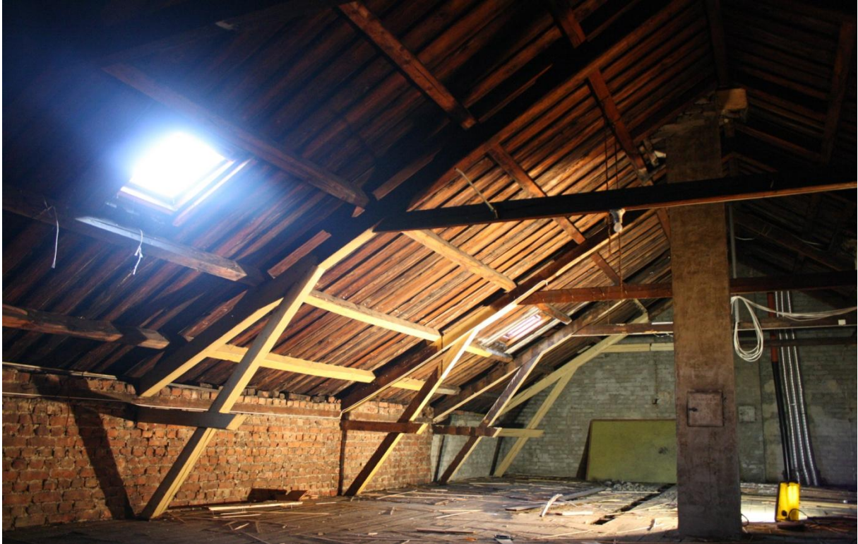
Bilde 3.1 – Loftet med synlig bæresystem
