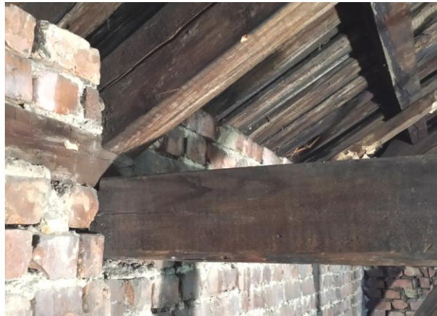
Bilde 3.13 – Hovedbjelke fastlåst mot forskyvning
