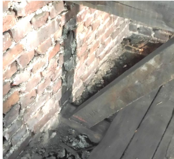
Bilde 3.9 – Skrå knebukk fastlåst i gulvbjelke
