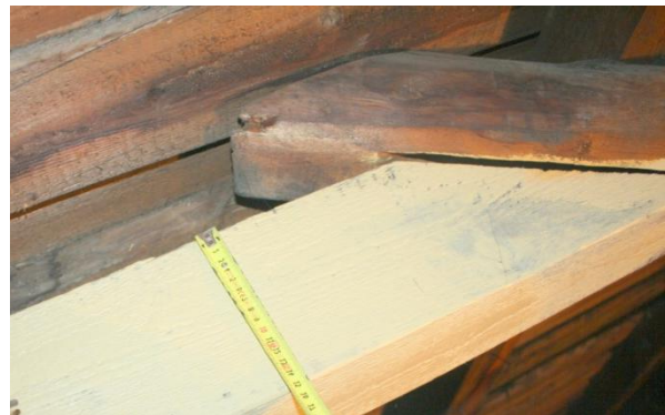
Bilde 3.11 – Redusert hanebjelke og hovedbjelke
