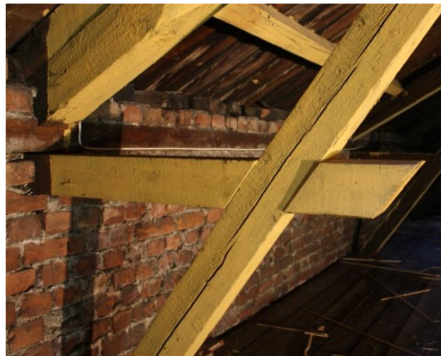
Bilde 3.8 - Kobling knebuikk (skrå) med knebuikk (horisontal)
