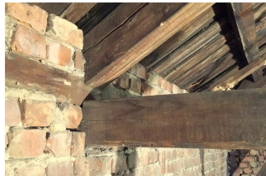
Bilde 3.3 – (2) Knebuikk horisontalkomponent og hovedbjelke mekanisk låst til tverrbjelke
