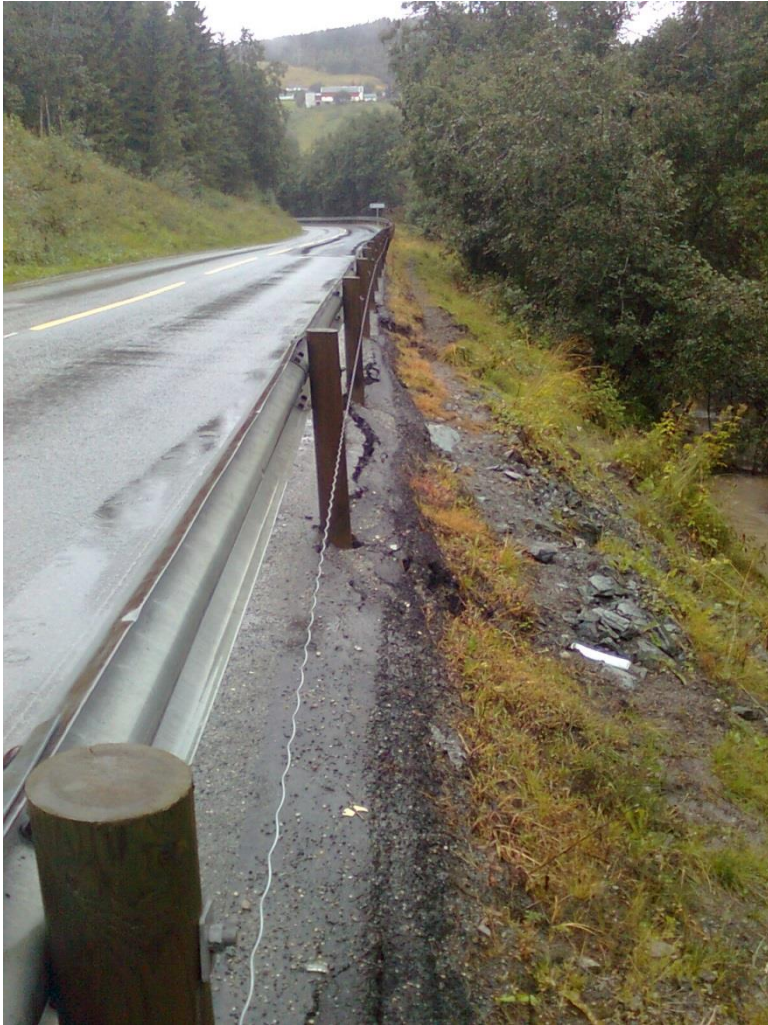
Figur 9: Vegen ligger i skråning, dermed vil man få en fylling på den ene siden, det kan resultere i en bratt asfaltkant
