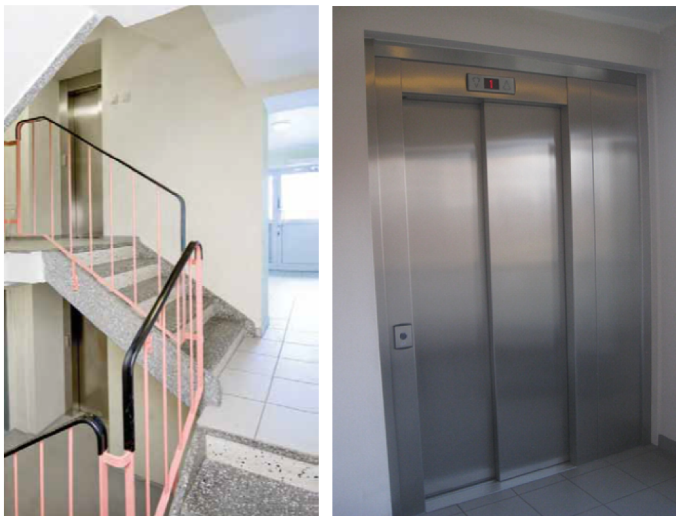
Figur 9: Eksempler på heiser utenfor trapperommet på Hamar. I begge tilfellene ble heisen plassert utenfor opprinnelig yttervegg, i tillegg til at inngangspartiet ble utvidet. Den ordinære trappen ble beholdt. T.v. Østre Børstad II borettslag. [65] T.h. Sørenga borettslag. [Foto: Privat]
