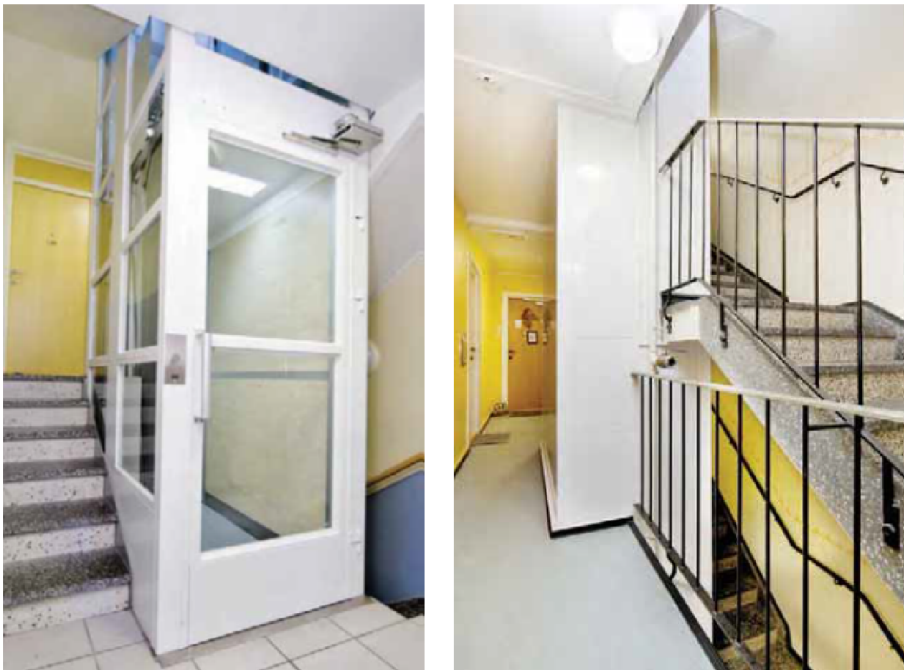
Figur 7: Eksempler på smalheiser på Hamar. T.v. Heisen i Mæhlumsløkka borettslag er plassert midt i trappeløpet i en toløps trapp. T.h. Heisen i Torvgata 103 borettslag er plassert i trapperommet der trappen har ett rett løp i hele etasjehøyden. Deler av trappeløpet er redusert til 70 centimeter for å gi plass til heisen. [65]
