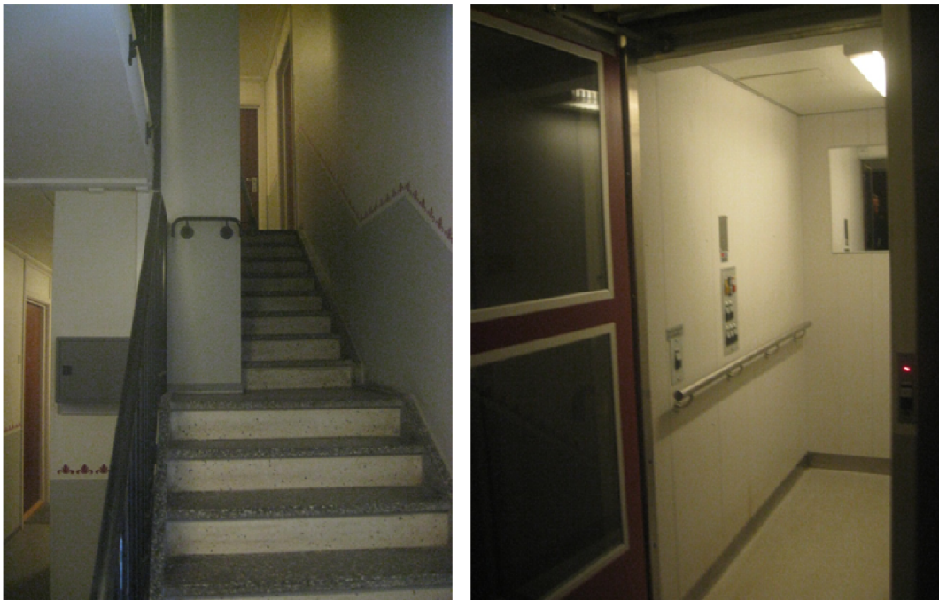
Figur 12: Smalheisen i Knaggen borettslag. T.v. Smalheisen ble plassert i trapperommet der trappen har ett rett løp i hele etasjehøyden. Deler av trappeløpet er redusert til 70 centimeter for å gi plass til heisen. T.h. Smalheisens innside. [Foto: Privat]
