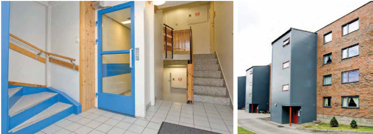
Figur 8: Eksempel på smalheis på Hamar. Heisen i Brubakken borettslag erstatter ett av løpene i en toløpstrapp, der det er bygget et tilbygg som rommer et nytt trappeløp. [65]
