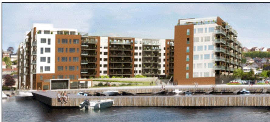
Bilde 1: Indre Vågen Atrium: Blokk K7 til venstre, K6 bak og K5 til høyre
