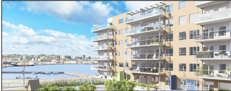
Bilde 2: Fasade, blokk K7
