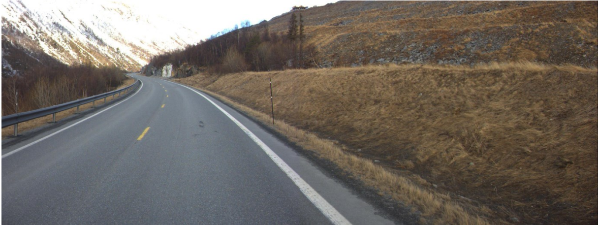
Figur 27 Eksempel med tilfredsstillende utforming av sideterrenget. E6 i Drivdalen, ca. 20 km sør for Oppdal. Bilde fra NVDB.
