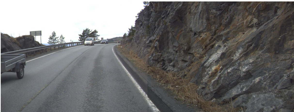
Figur 26 Eksempel med kort avstand mellom kantlinje og fjellskjæring. E6 ca. 6,5 km nord for Verdal. Bilde fra NVDB.
