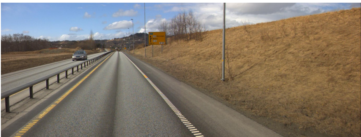
Figur 28 Eksempel på ny veg med god utforming av sideterrenget. E6 ca. 500 meter sør for Melhus. Bilde fra NVDB.
