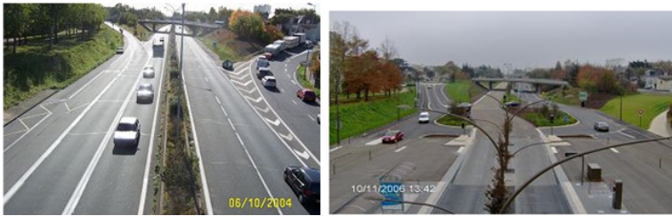
Figur 4.25: Etablering av høystandard kollektivtrase i Nantes i Frankrike. Ved hjelp av signalregulering har bussene i det midtstilte kollektivfeltet forkjøringsrett gjennom rundkjøringen. (Kvambe et al., 2009)
