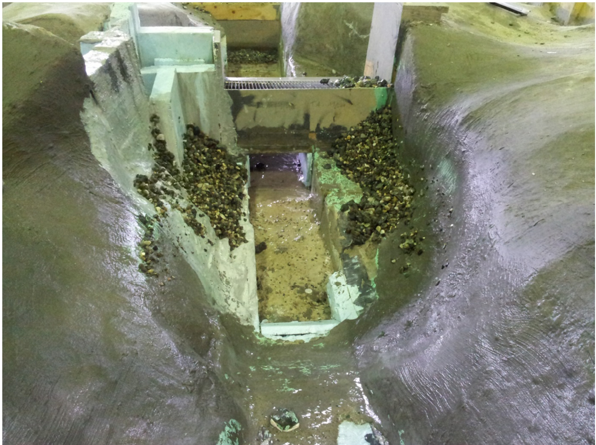
Figur 3.14: Sedimentforhold i inntaket ved slutten av spyling. 4 m 3 /s og 100% fyllingsgrad
