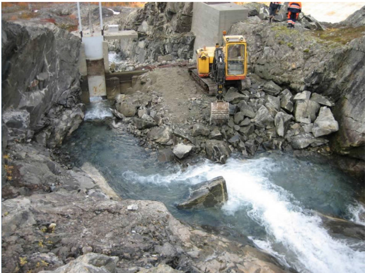
Figur 1.1: Fjerning av sedimenter fra inntaket. Brede spyleluke ca. 1 m. [Paulsen & Grane, 2009]
