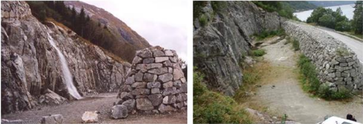
Figur 20: Foto av fangvoll med bratt tørrmur langs Rv 7 Indre Rotagjelet, Hordaland (Norem 2011 Figur 8.25).
