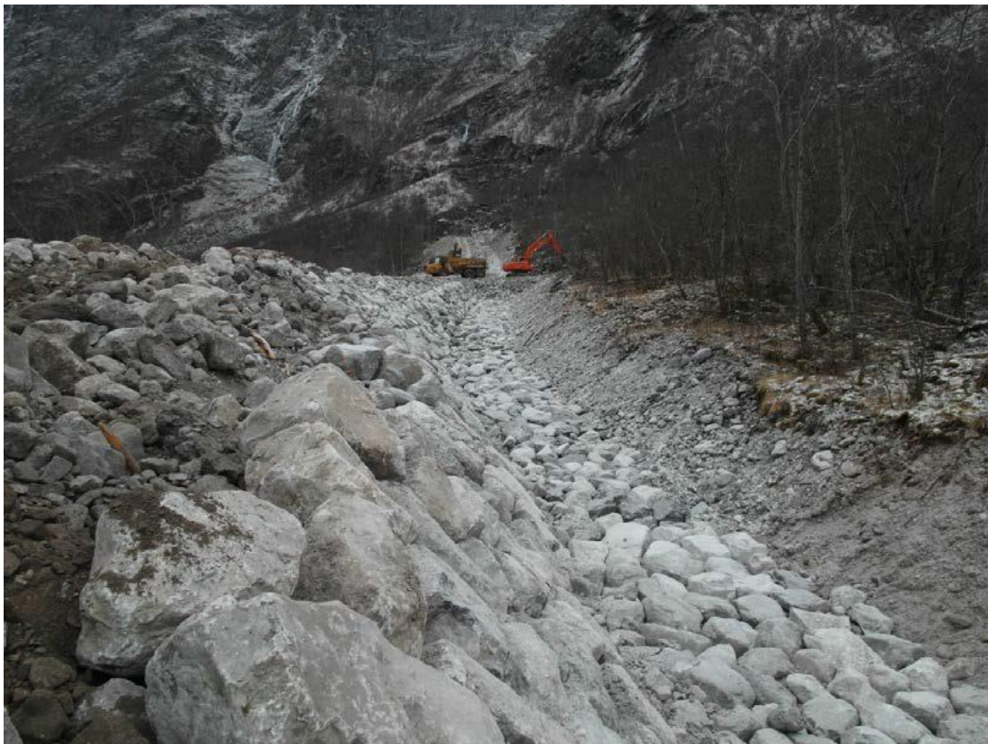
Figur 14: Foto av erosjonssikring i Hallinggrovi (Høydal & Kronholm 2013 Figur 28).
