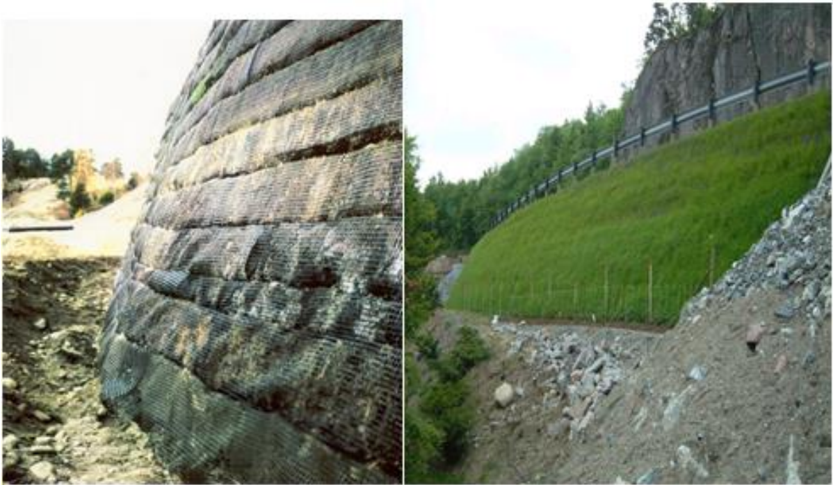
Figur 16: Bratte skråninger med armert jord (foto: SINTEF).
