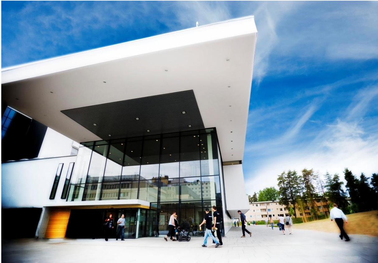
Figur 25 Hovedinngangen til Ahus ( © Akershus universitetssykehus, 2012a)
