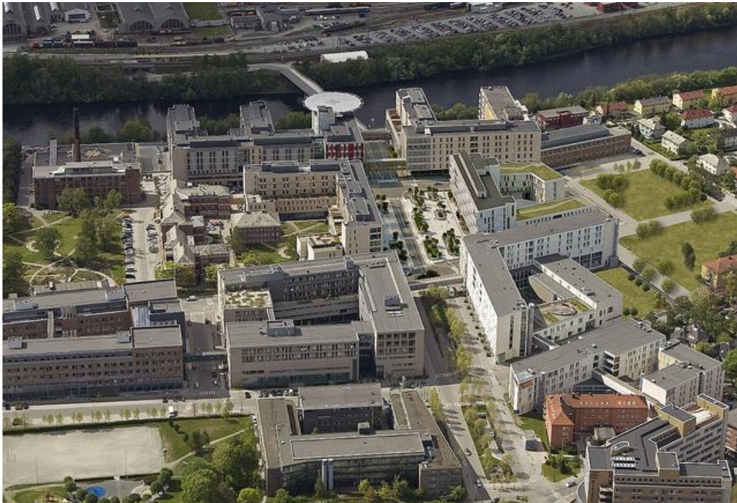
Figur 6 Fotomontasje av St. Olavs Hospital i 2013 illustrer oppdelingen av et lavt sykehus i ulike bygningskropper og transportsystemet (St. Olavs Hospital, 2008)
