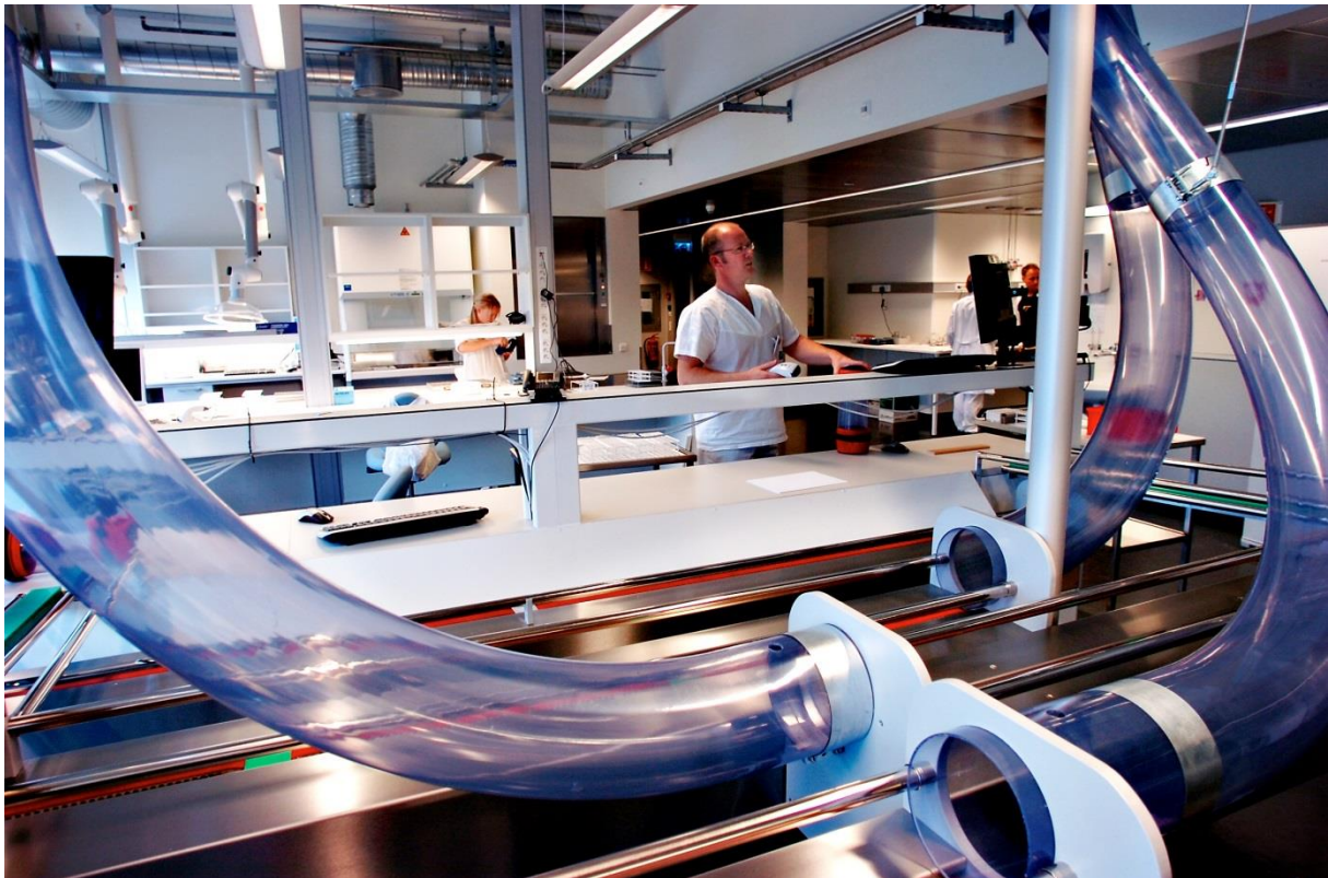
Figur 8 Rørpostsystemet på prøvemottaket i Labororiesenteret, St. Olavs Hospital (© Helsebygg Midt-Norge, Ukjent-b)
