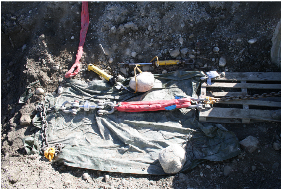
Figur 6.9 Oppsett for uttrekking av rør, uten jekk
