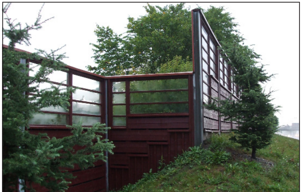
Støyskjerm kombinert med jordvoll. E6 Omkjøringsvegen i Trondheim
