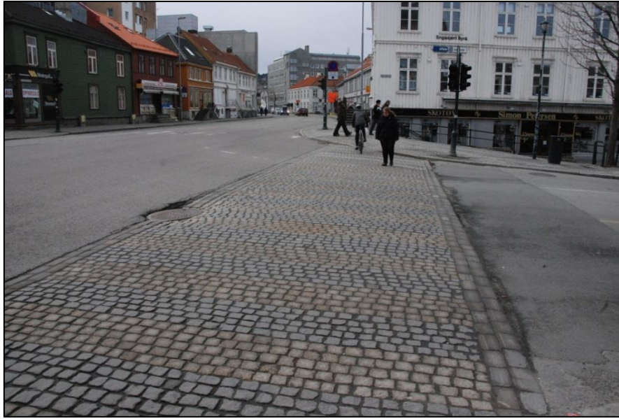
Figur 78: Bruk av brostein som oppmerking av gangfelt i Munkegata
