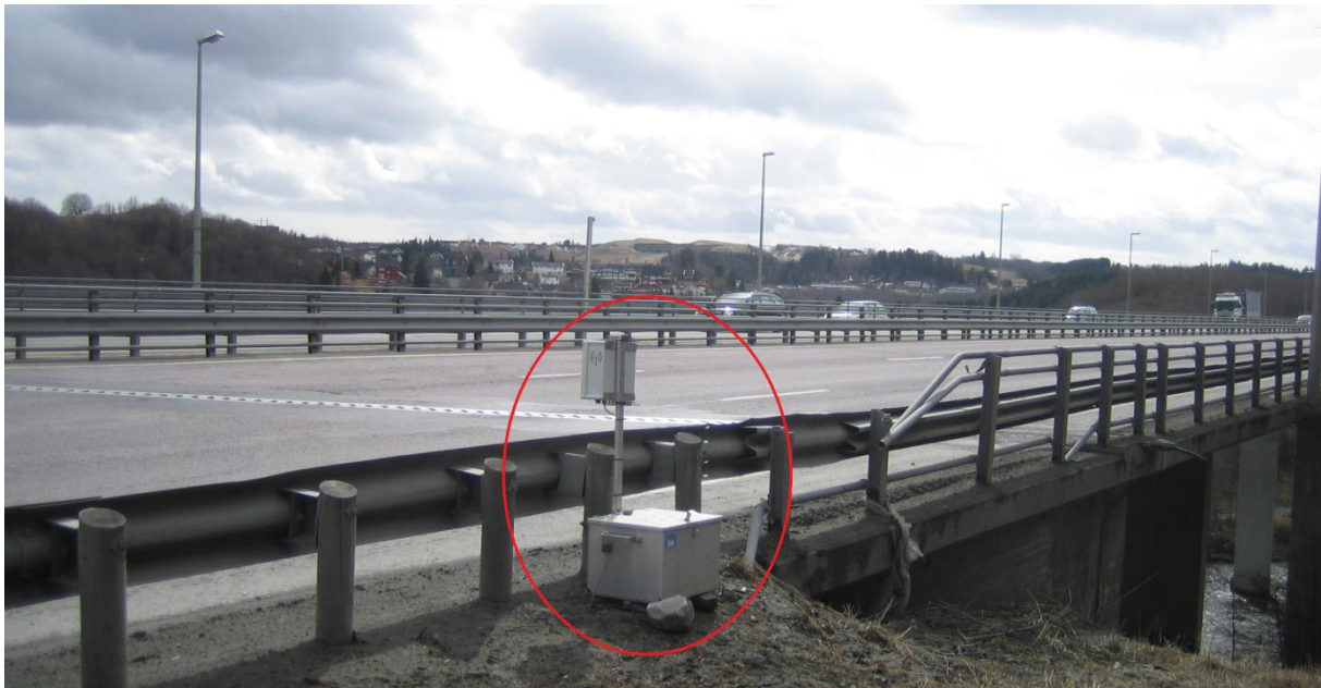
Figur 26 Sensorplassering ved Kroppanbrua
