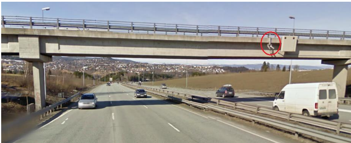
Figur 33 AutoPASS-antenne i Okstadbakken
