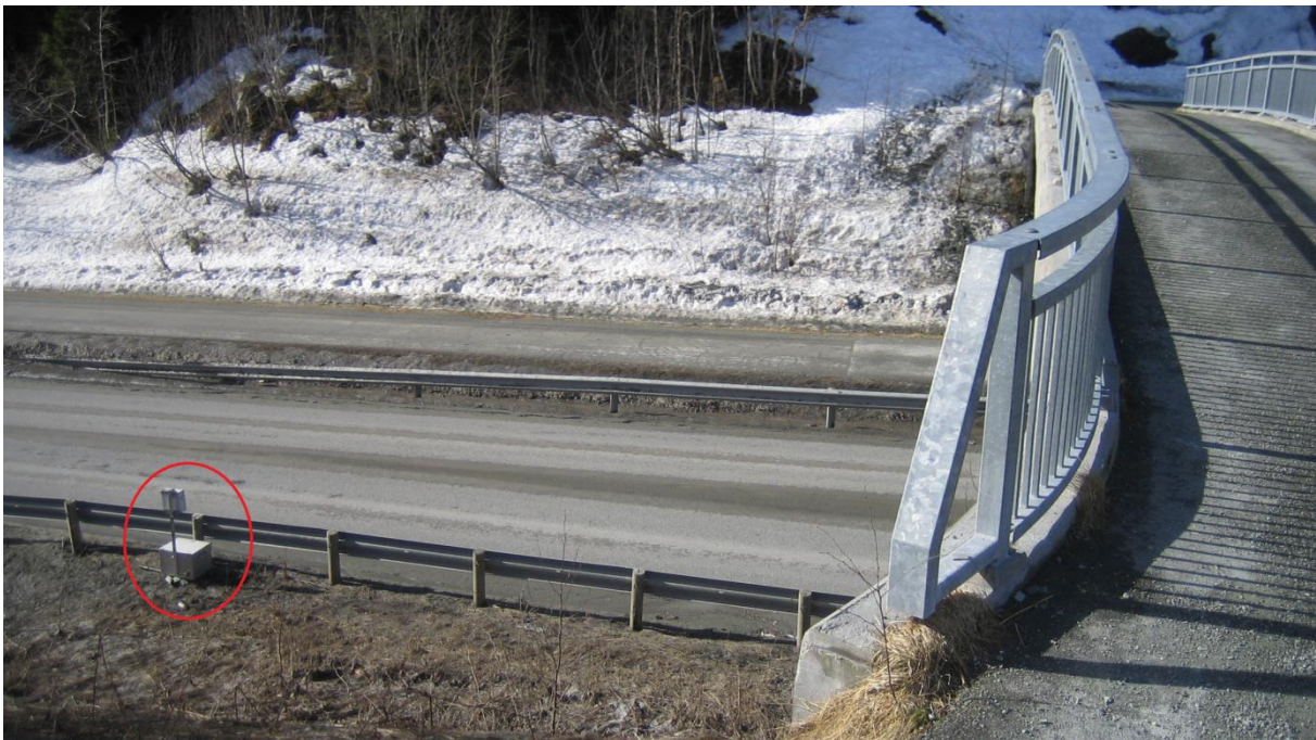
Figur 28 Sensorplassering i Kongsvegen
