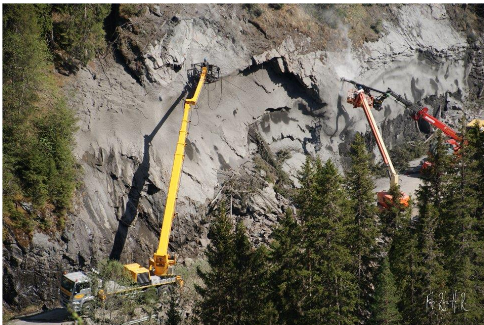
FIGUR 34: RASSIKRING, HER VIST ETTER ET RAS VED EGGAFOSSEN I HOLTÅLEN. FOTO: RITA H. RØNNING[74]
