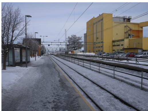
Figur 41: Stange stasjon, ser mot Hamar
