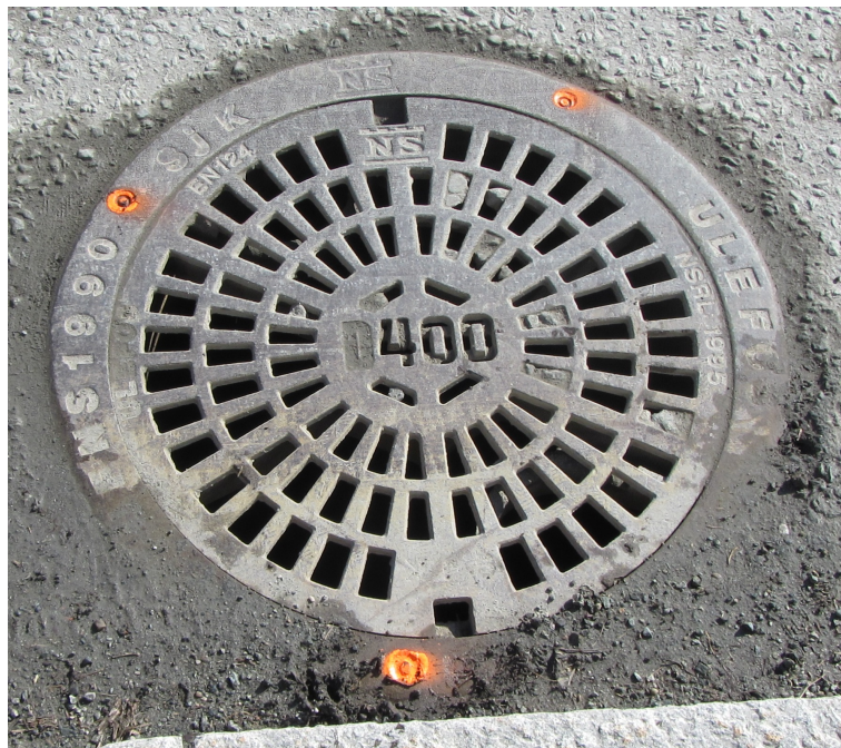
FIGUR 3.6: Innmåling av sirkelformet kum med GNSS
