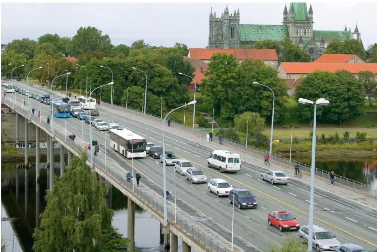
Bilde 23: Situasjonen på Elgeseter bro høsten 2008 etter innføringen av kollektivfelt. Bilde: Steinar Simonsen, SVV
