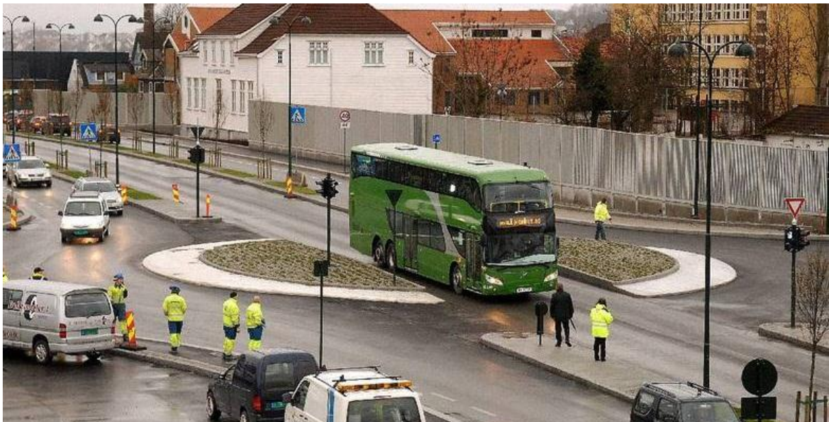
Bilde 12: Første buss gjennom sentraløya på Fv44 i Stavanger. Biltrafikken holdes igjen før rundkjøringen med rødt lys når det kommer buss. Bilde fra Aftenbladet
