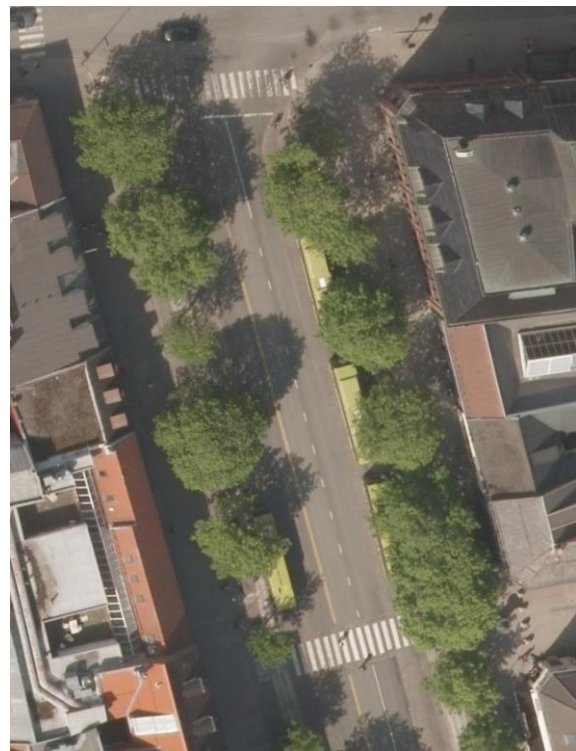
Bilde 38: Bussholdeplassen Munkegata M5 på høyre side. Har plass til tre busser. Flyfoto fra Trondheim kommune
