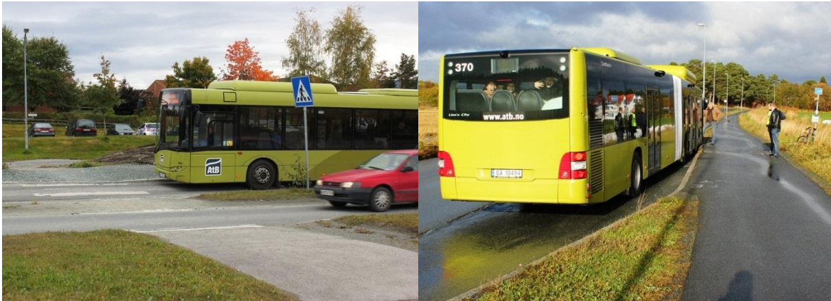
Bilde 3: Til venstre: Busslomme i Trondheim som oppfordrer biler til å kjøre forbi rett ved gangfelt Til høyre: I Trondheim er de fleste busslommene for korte for leddbussene
