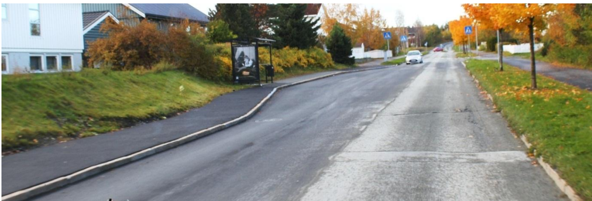
Bilde 2: Busslomme på en oversiktlig veg i Trondheim med lite trafikk. Blir lite plass igjen til fortau og fotgjengere, spesielt ved leskuret. For bedre prioritering av gående og busser burde holdeplassen vært utformet som kantsteinsstopp
