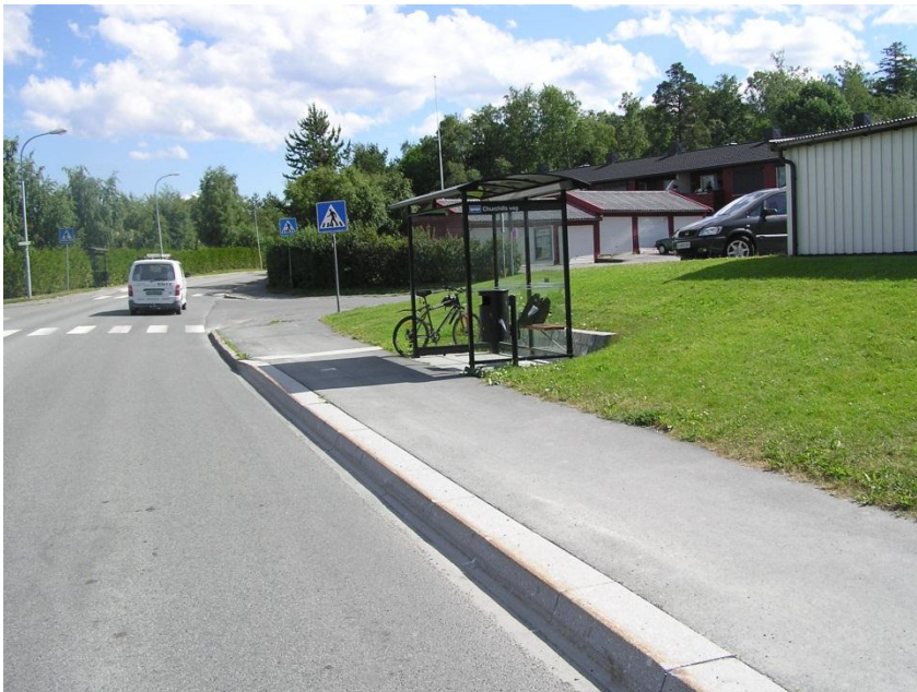
Bilde 4: Eksempel på holdeplass i Trondheim. Her er det benyttet Kassel kantstein med avrundet profil mot busshjulet. Gjør det mulig å legge bussen helt inntil plattformen uten å skade hjulet.
