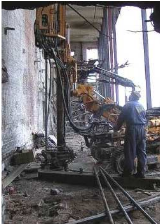
Figur 24 Installasjon av injeksjonspeler under trange forhold (Aronsson et al. 2004).
