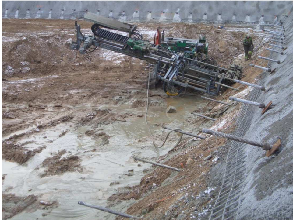
Figur 26 Søl av gysemasse kan gi krevende arbeidsforhold. Bildet er tatt i forbindelse med feltarbeidet studenten gjennomførte ved Siemens nye hovedkvarter i Oslo.
