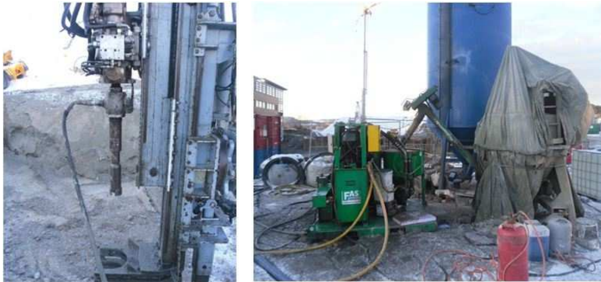
Figur 8 Til venstre vises deler av rigg med hydraulisk topphammer og tilkoblet injeksjonsslange. Til høyre vises eksternt blandeverk, samt betongblande og pumpe. (FAS 2010).
