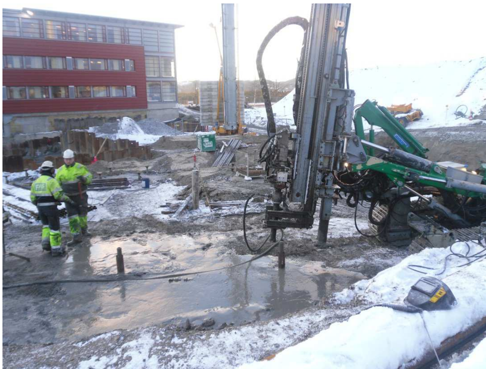
Figur 38 Boring av injeksjonspeler nær eksisterende kontorbygg ved prosjektet Statoil – Stjørdal (Andersson 2011).
