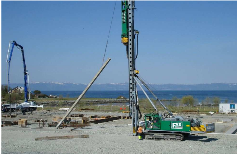
Figur 19 Bæredyktig underlag som gir sikker oppstilling av pelerigg (FAS 2011).
