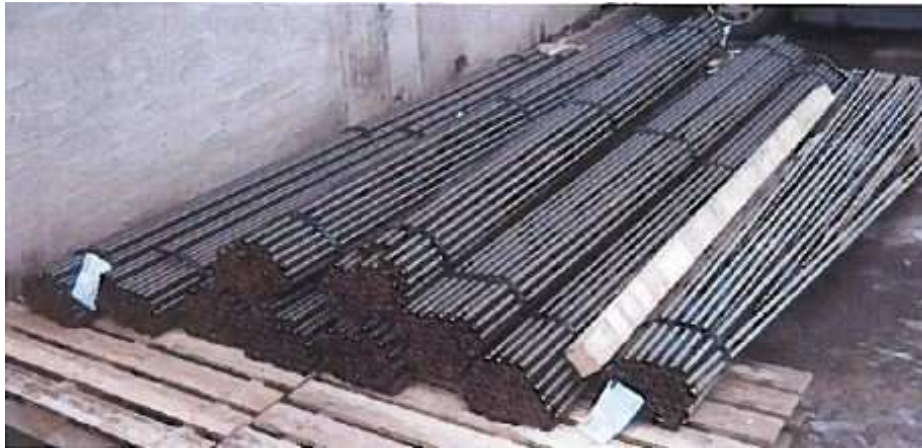
Figur 25 Oppbevaring av injeksjonspeler krever liten plass på byggetomten (DeNeef 2010).
