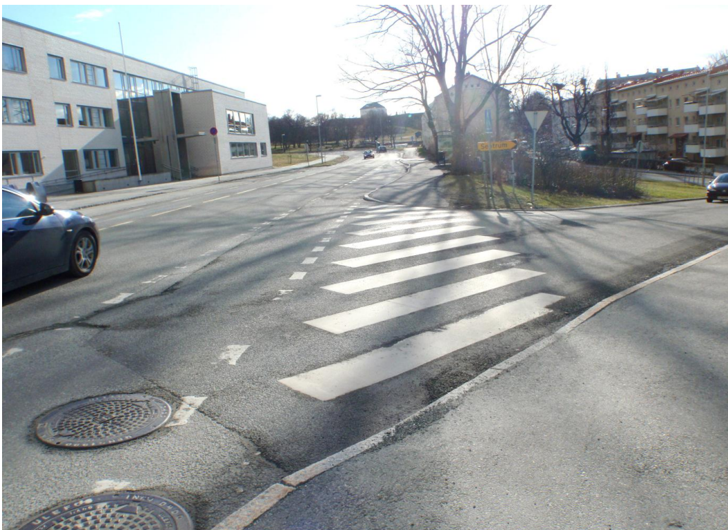
Bilde 5: Gangfelt nummer 6 i Fv 865, her ligger gangfeltoppmerkingen på skrå og ikke vinkelrett over kjøreretningen (Foto: Tine Solem)
