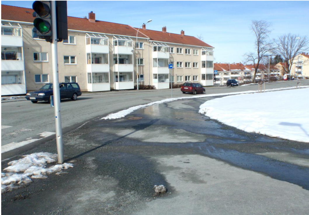
Bilde 7: For lav lyshetskontrast i oppmerksomhetsfeltet, samt varselsfeltet ved gangfelt 4
