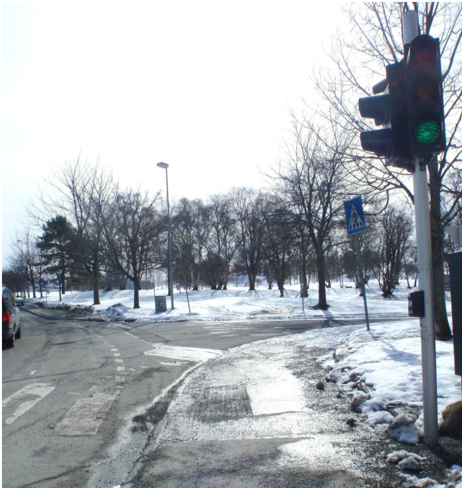
Bilde 6: Trykknappen ved gangfelt 4, mangler taktil angiving av gatekryssingen (Foto: Tine Solem)
