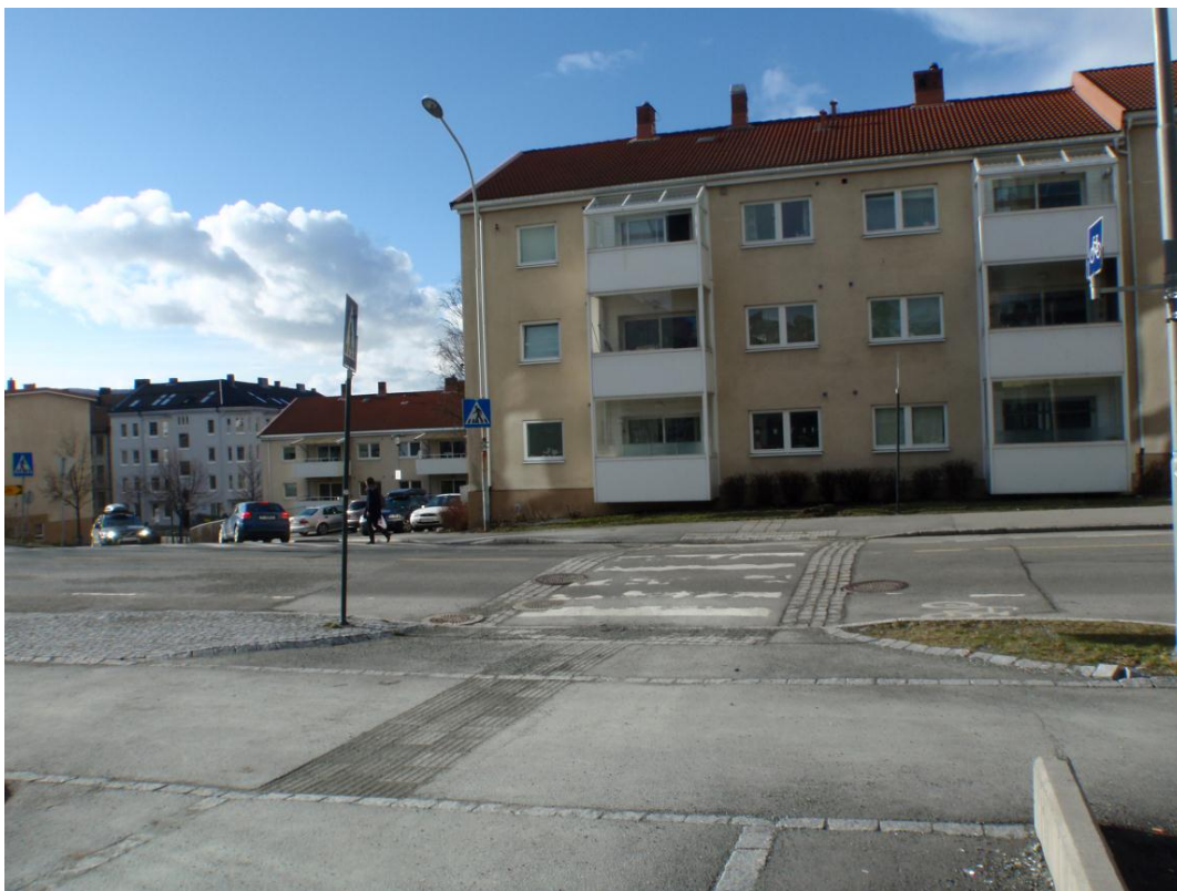
Bilde 8: For lav lyshetskontrast i oppmerksomhetsfeltet, samt varselsfeltet ved gangfelt 7
