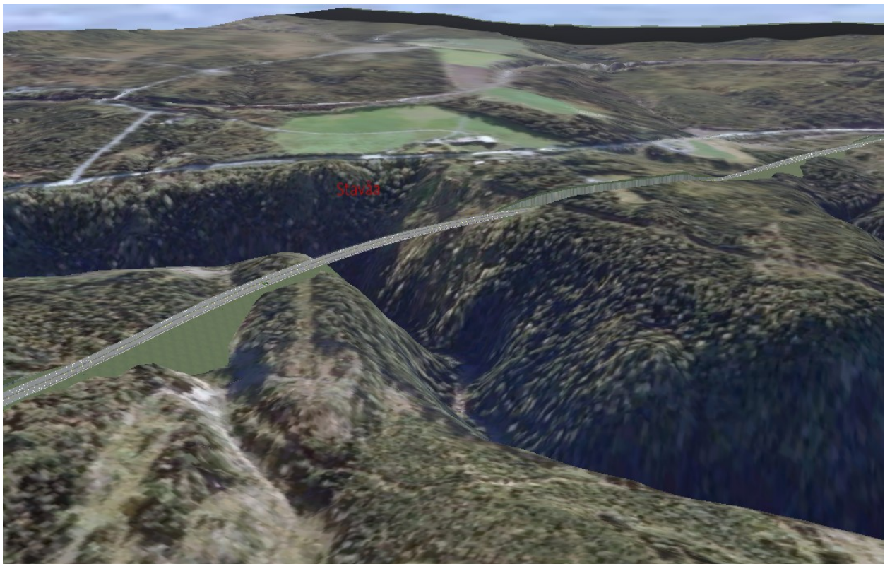
Figur 41: Ny bru over Stavåa sett fra nord-vest
