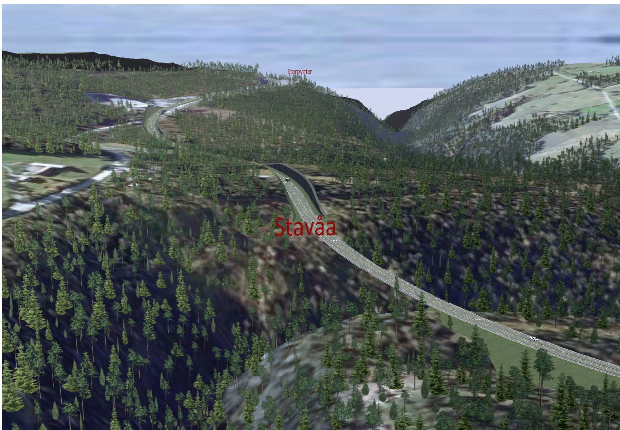
Figur 62: Terrenginngrep ved Stavåa sett fra nord
